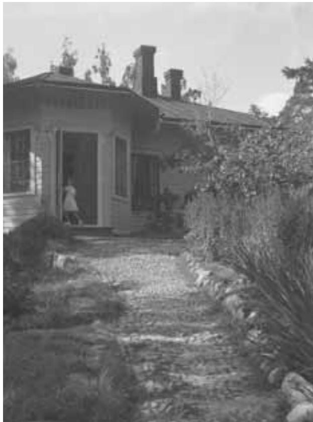
Yllä: Päärakennuksen edustan kivitukimuur 1926 / HKM Alla ja vier. sivu ylhäällä: Käytävä päärakennukselta rantaan oli huolellisesti kivetty. Koristeistutuksissa mm.... Eino Finne 1935 / TW
