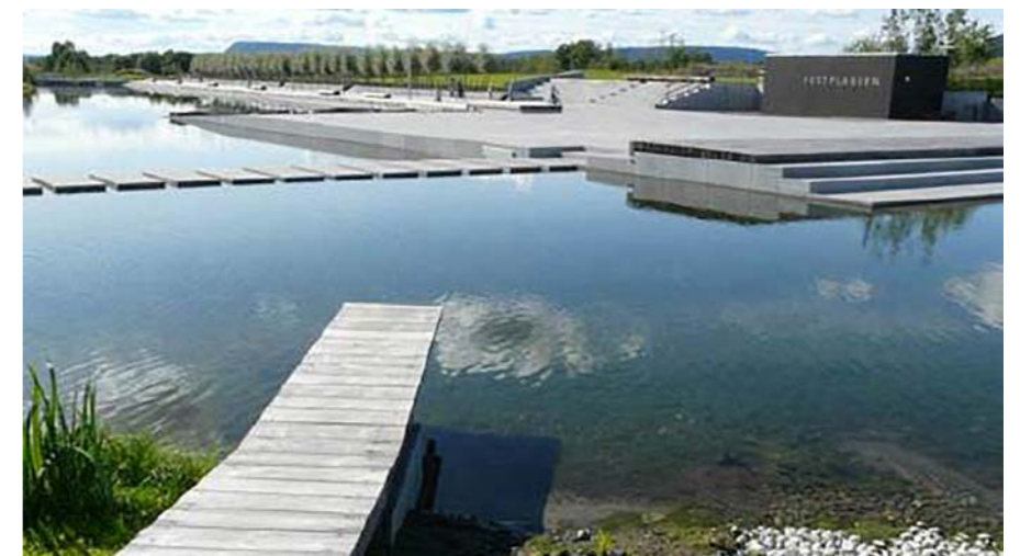
Kuvakollaasi 3.11. Laaja-alaisista hulevesien käsittely- ja viivyttämiskalteista yleisillä alueilla. Ylimmällä rivillä vas. ja kesk. Parc Clichy Batignollesin Martin-Luther-Kingin puiston kaupunkimaisesti rakennetut hulevesialtaat. Alimmalla rivillä vas. ja kesk. istutettuja hulevesipainanteita samassa puistossa. Ylimmällä rivillä oik. ja keskimmaisella rivillä oik. Tanner Springs Park Portlandissa. Hulevedet kerätään ja johdetaan puiston alimmassa kohdassa sijaitsevaan altaaseen, jonka päälle on rakennettu esiintymislavanakin toimiva polku. Keskimmaisella rivillä vas. hulevesikosteikko Järvenpään Lepolassa, kesk. hulevesiallas katualueella Kööpenhaminassa. Alimmalla rivillä oikealla laaja hulevesiallas Fornebun puistossa Oslossa.
