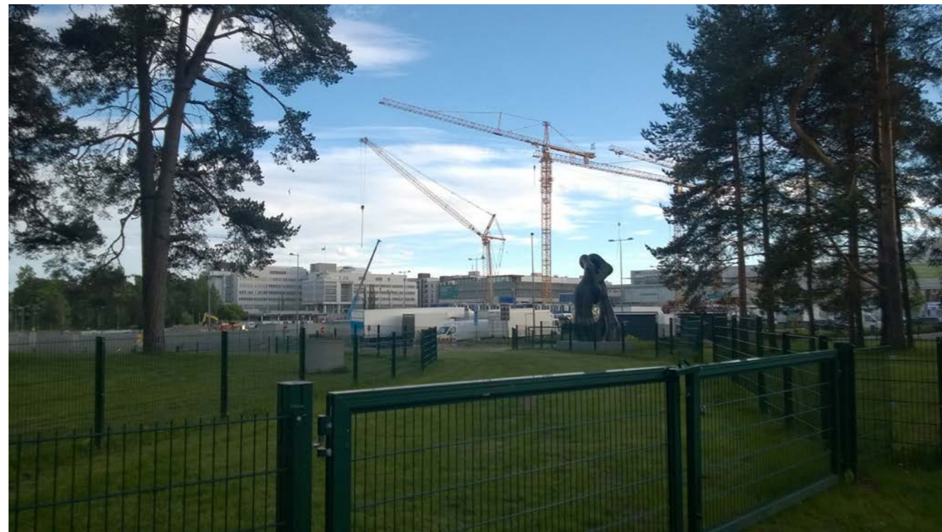
Kuva 3.2 Puistoalue on suojattu rakennustöiltä aitaamalla ja ohjaamalla kulkureitit hallitusti.
