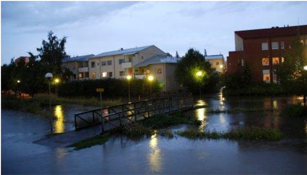
Kuva 7. Hulevesitulva Mätäpuron liepeillä 22.8.2011 rankkasateen jälkeen © Rakennusvirasto
