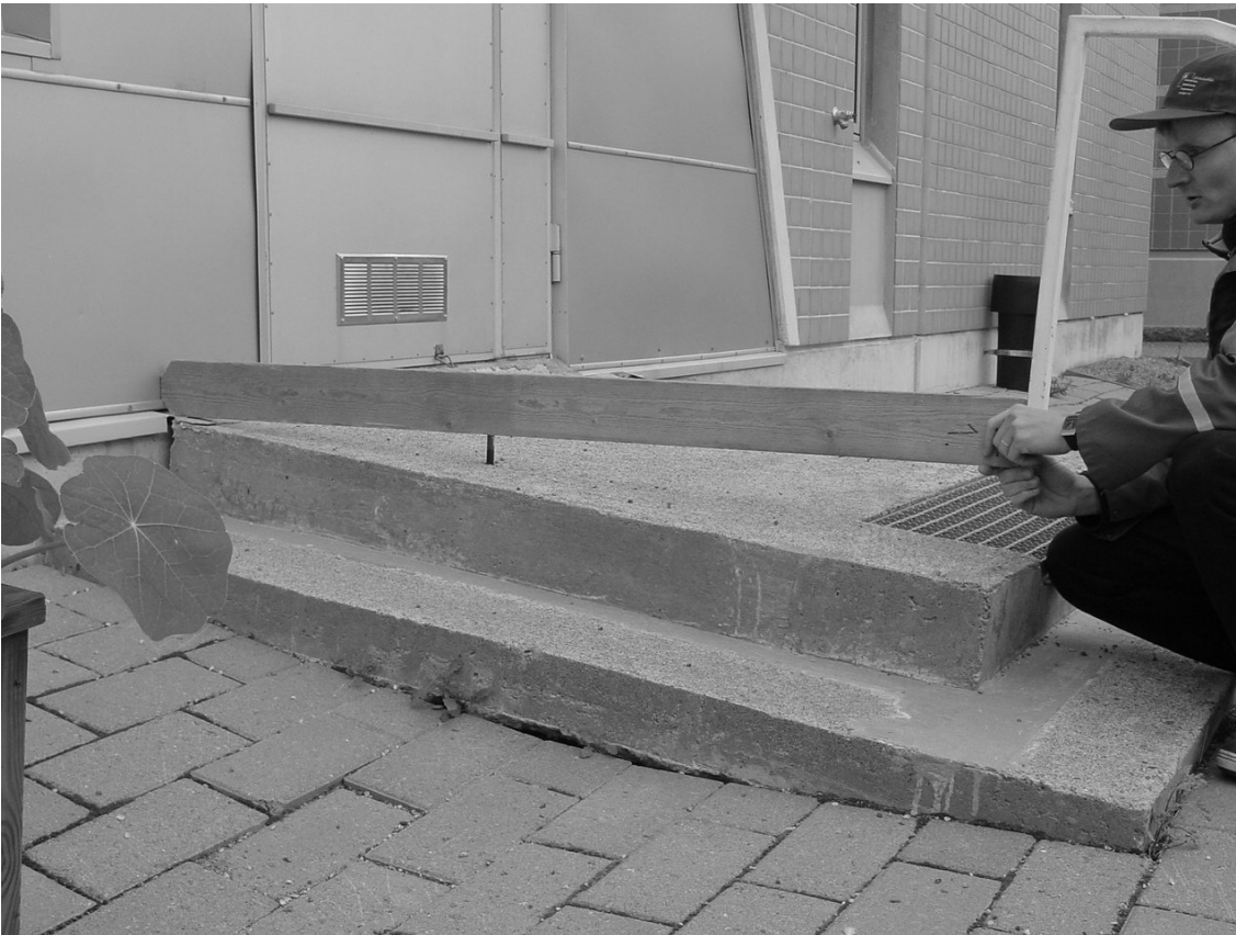
Kuva 10 Pikku- Huopalahdessa esiintynyt erään paalutetun painumattoman rakenteen sekä paaluttamattoman esirakennetun rakenteen rajakohtaan muodostunut painumaero /15/.
