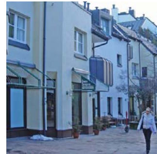
liiketila erottuu selkeästi asunnoista katukuvassa, München
