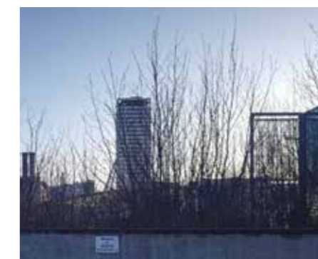
1. Vuosaaren nykyisin ainoa tornitalo Cirrus erottuu alueella useista suunnista katsottaessa. Tulevaisuudessa Vuosaaren keskusta kahaha lisää Cirruksen korkoon yltäviä tornitaloja, etenkin Vuotien eteläpuolelle.
