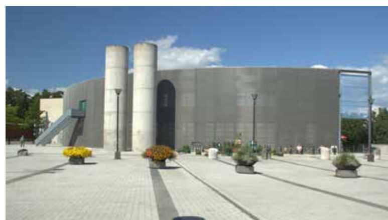
Vuotalon kaareva julkisivu rakenteineen luo aukiolla tunnistettavan taustan.
