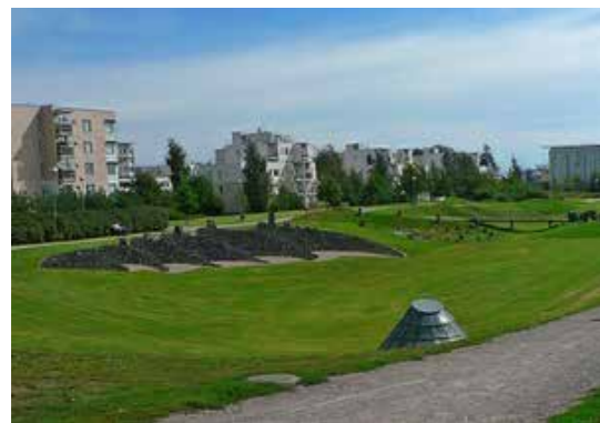
paikallisia hulevesiä keräävä, imeyttävä ja viivyttävä nurmipainanne on viittaus Mustankivenpuiston avaimesta maisemasta
