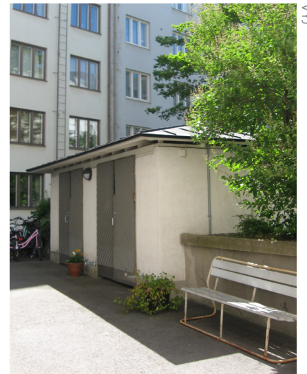
Töölöntorinkatu 4:n ja 6:n yhteinen jätesuoja on rakennettu vuonna 2009.
