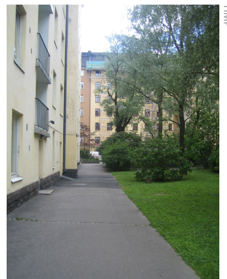
Maltillisesti ja tarkoituksenmukaisesti käytettynä asfaltti on käyttökelpoinen materiaali, jolla voidaan vaikuttaa myös hulevesien virtaamiseen. Laaja vihervalue pehmentää kokonaisuutta. Kuva Mannerheimintien, Savilankadun, Urheilukadun ja Sallinkadun rajaamasta korttelista.
