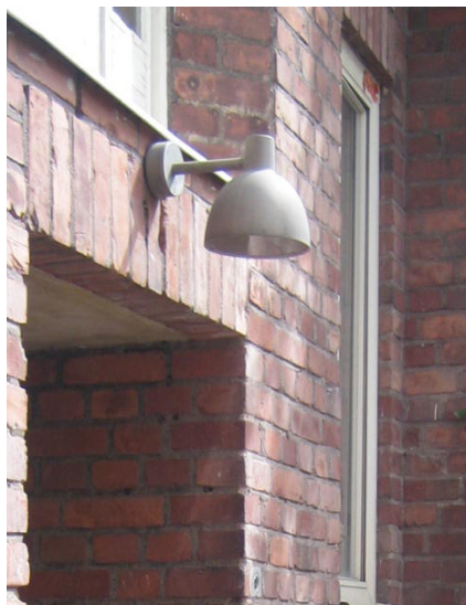
Uudempi julkisivuun kiinnitetty pihavalaisin. Pihavalaistuksen parantamisen tarve on hyvä arvioida myös julkisivukorjauksen yhteydessä, jolloin sähkövetojen tekeminen on helpompaa.
