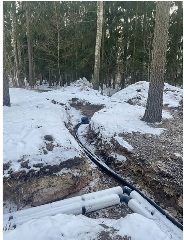
Kuvat 25, 26, 27 ja 28. Maalämmön keruuputkistojen kaivantoja, jotka kulkevat hyvin lähellä puita vaurioittaen niiden juuristoja. Puiden runkoja ei ole suojattu ja kaivumaita on läjitetty puiden juuristoalueille.
