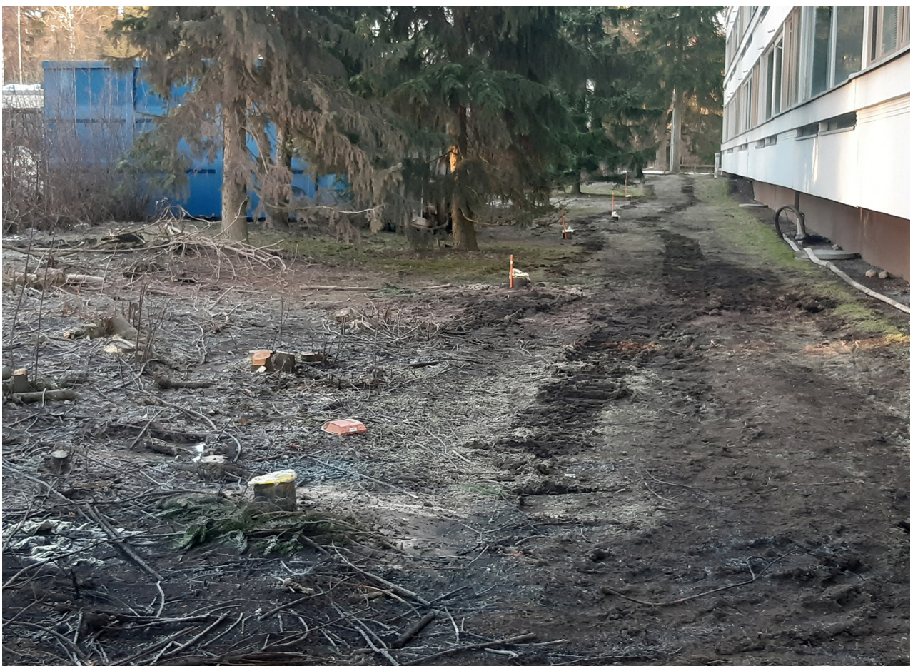
Kuvat 23 ja 24. Liikkuminen raskaalla kalustolla kasvillisella alueella aiheuttaa puiden juuristoalueen maaperän tiivistymistä.
