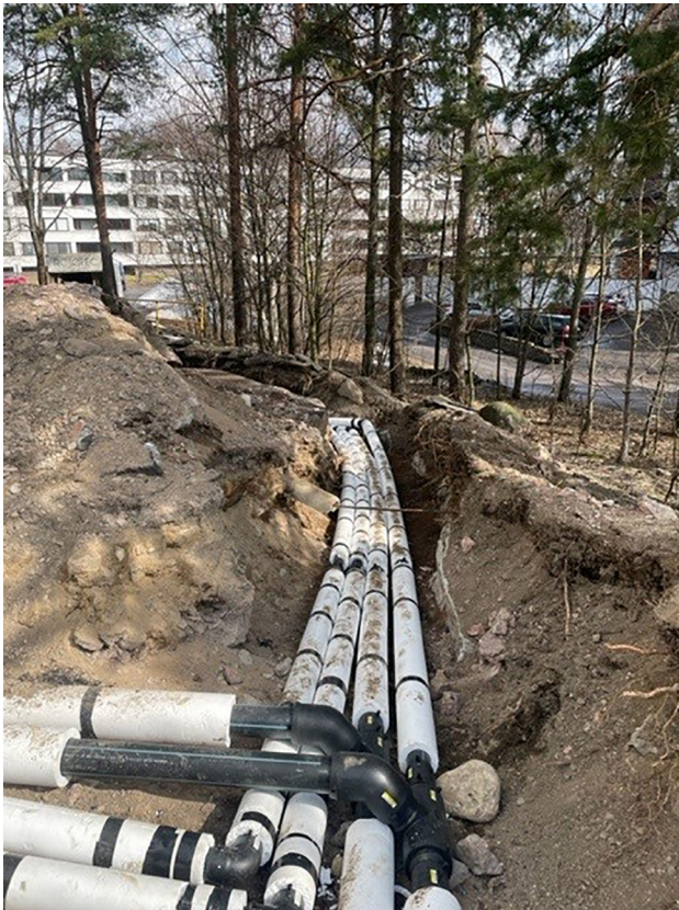
Kuvat 20 ja 21. Keruuputkistojen kaivannot kulkevat hyvin lähellä puita vaurioittaen niiden juuristoja.
