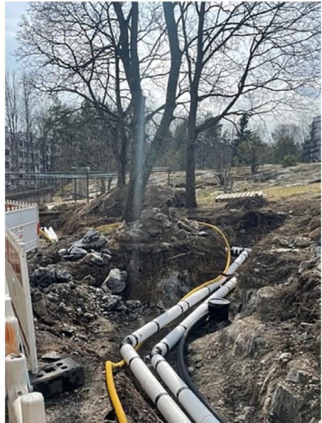
Kuvat 20 ja 21. Keruuputkistojen kaivannot kulkevat hyvin lähellä puita vaurioittaen niiden juuristoja.
