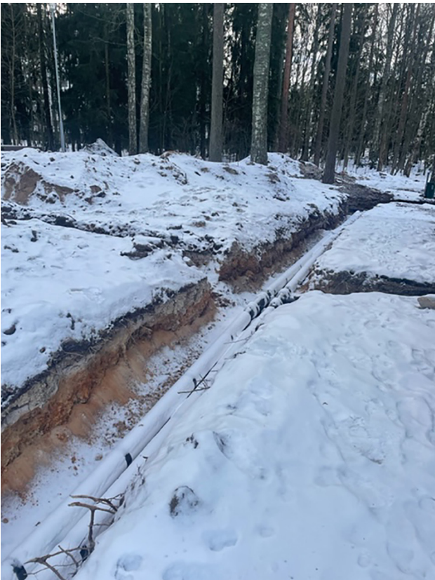
Kuvat 25, 26, 27 ja 28. Maalämmön keruuputkistojen kaivantoja, jotka kulkevat hyvin lähellä puita vaurioittaen niiden juuristoja. Puiden runkoja ei ole suojattu ja kaivumaita on läjitetty puiden juuristoalueille.
