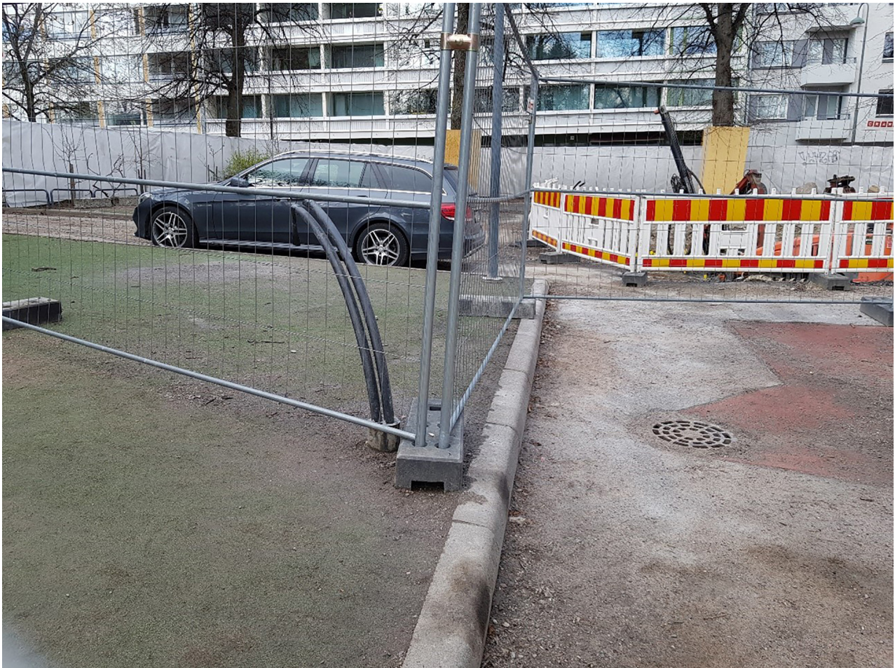
Kuvat 13 ja 14. Valmis kaivo, josta on näkyvissä kaivonkansi ja putkistot. Siirtoputkistoa ei ole vielä kaivettu.
