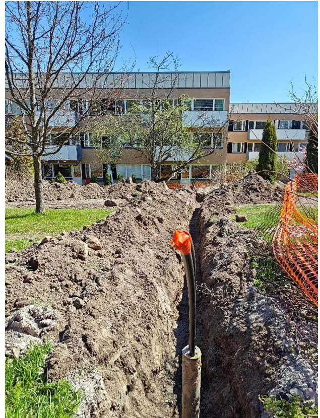
Kuvat 29 ja 30. Maalämmön keruuputkiston kaivantoja. Avoimella nurmialueella kaivannoista ei aiheudu häirtäviä vaikutuksia pihakasvillisuudelle.
