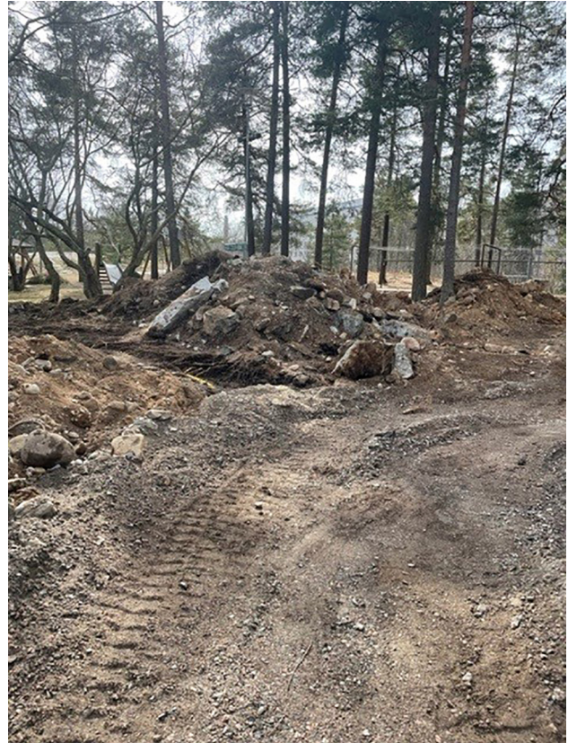
Kuva 19. Kaivantojen maita on läjitetty puiden juuristoalueelle.
