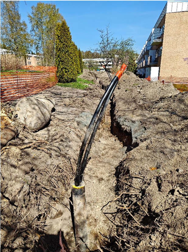
Kuvat 29 ja 30. Maalämmön keruuputkiston kaivantoja. Avoimella nurmialueella kaivannoista ei aiheudu häirtäviä vaikutuksia pihakasvillisuudelle.
