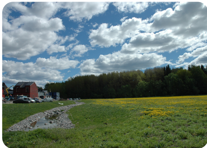
Kuva 9. Uusien asuinalueiden hulevesiä hallitaan viivytysaltaissa ennen kuin ne laskevat Longinojaan.
