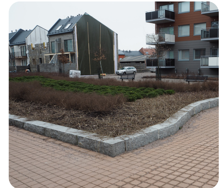
Kuva 7. Sven Grahnin puisto sijoittuu rakenteilla olevan Ormuspellon asuinalueen keskelle.
