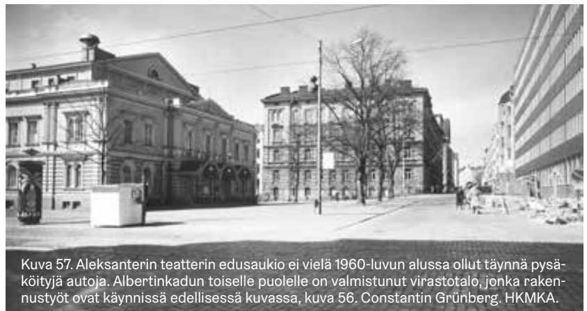
Kuva 56. Albertinkadun ja Bulevardin kulmatontilla oli rakennustyömaa joulukuussa 1957. Constantin Grünberg. HKMKA.
