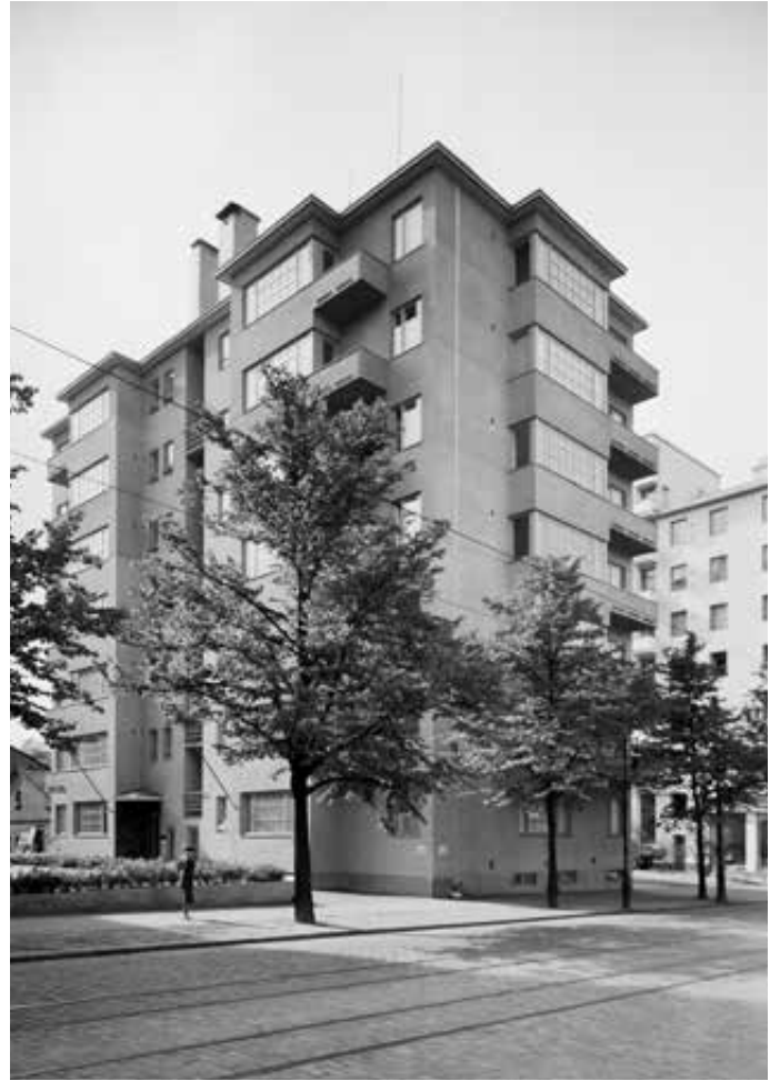
Kuva 62. Bulevardin länsiosaan rakennettiin funktionalististyyllisiä kerrostaloja, tässä Bulevardi 34 a. A. Pietinen Oy, 1940. HKMKA.
