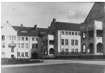
Pohjoisosan rakentaminen on tiivistä ja korkeaa. Se rajaa tilaa ja näkymiä voimakkaasti.
