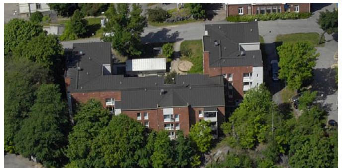
Vuonna 1987 valmistui, entisen Deckerin suunnitteleman ja jo revityn pää- rakennuksen paikalle, Helsingin kaupungin työntekijöiden asuintalo, Au- roranlinna, suunnittelijana Sakari Laitinen. KSV/kaupunkimittausosasto.
