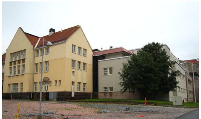
Meckelininkadun ja Lapinlahdenkadun kulmaan 1992 valmistunut uudisrakennus.
