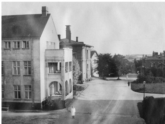
Näkymä pohjoiseen n. 1920 -luvulla (tarkka aika tuntematon). Renkaanjäljet näkyvät tiivistymättömässä sorapinnoitteessa. HKM.
