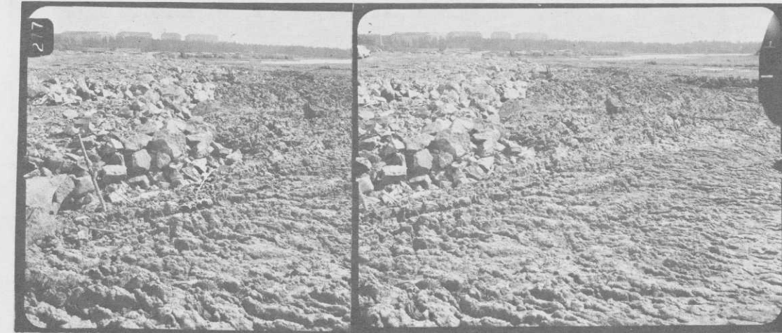
Painava louhoskivitäyte on ajettu savi-kerrosten päälle.
