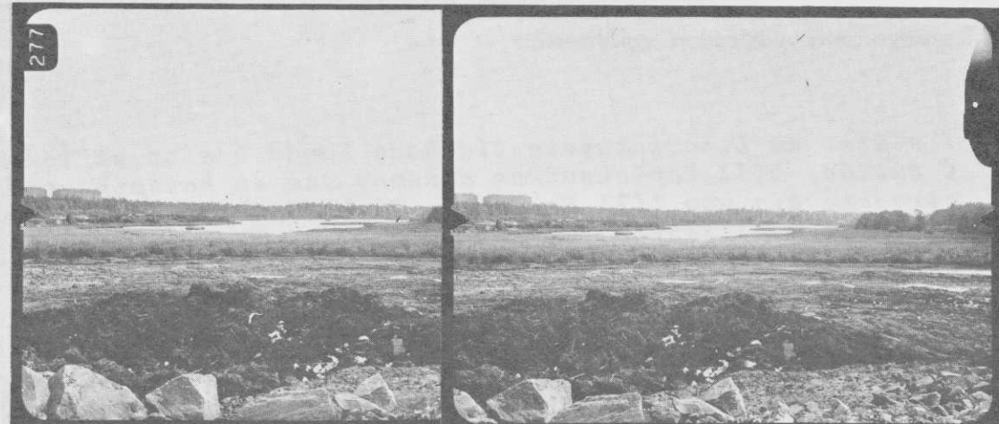
Louhoskiviä ja maantäyttöä savi-kerroksen päällä, huomaa ruovikon selvä raja.
