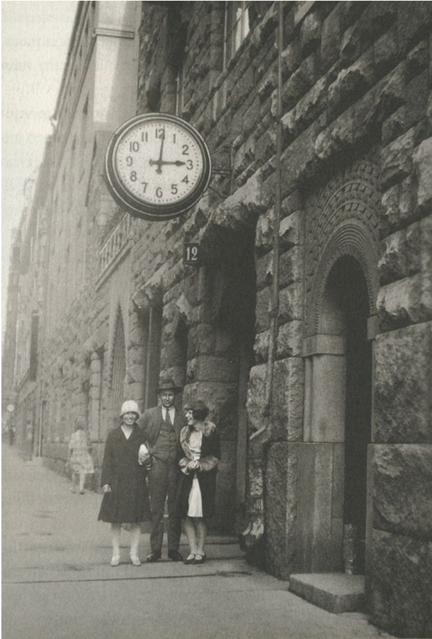
Otavan suuri kello asennettiin paikalleen vuonna 1926.
