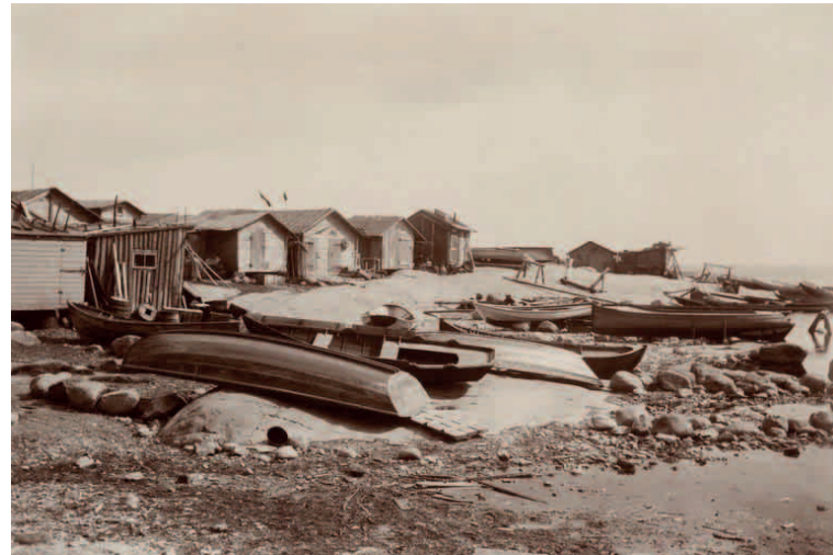
Kuva 61. Ranta-alueita käyttivät alun perin kalastajat ennen alueen rakentumista 90 . Kuvassa kalastajien kotoja ja veneitä Hietalahden eteläpuolella Munkkisaarella vuonna 1911. Kuvaaja tuntematon, HKM.
