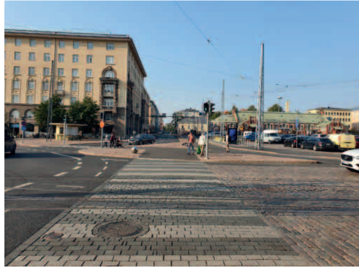
Kuva 121. Bulevardin risteysalueen vaihtelevat kiveykset ja asfaltti.
