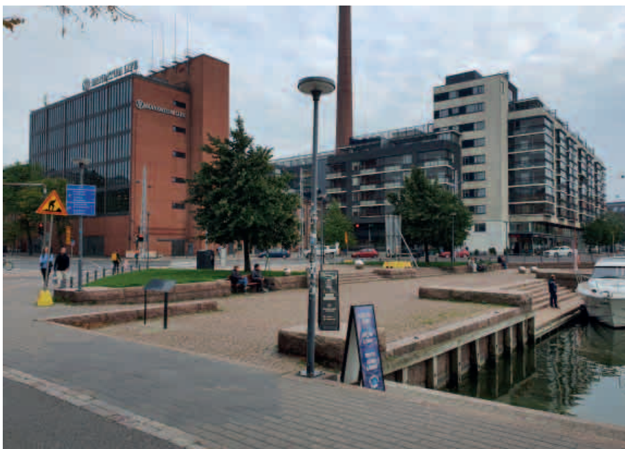
Kuva 115. Rantamuuria ja ranta-alueen rakenteita.
