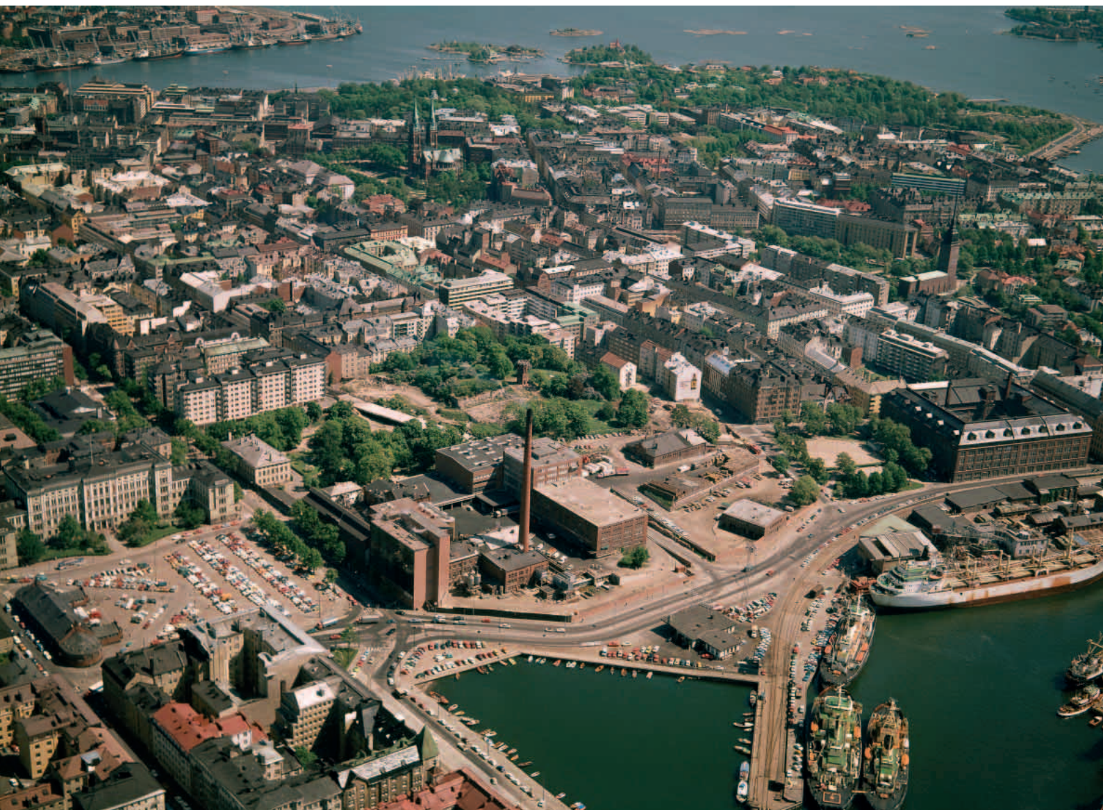
Kuva 52. Ilmakuva vuodelta 1973. Mallaskadun tunneli ja Bulevardin kulman uusi keittorakennus ovat valmistuneet. Hietalahdentori ja Hietalahdenaltaan päätyaukio toimivat pysäköintialueina. SKY-FOTO Möller, HKM.
