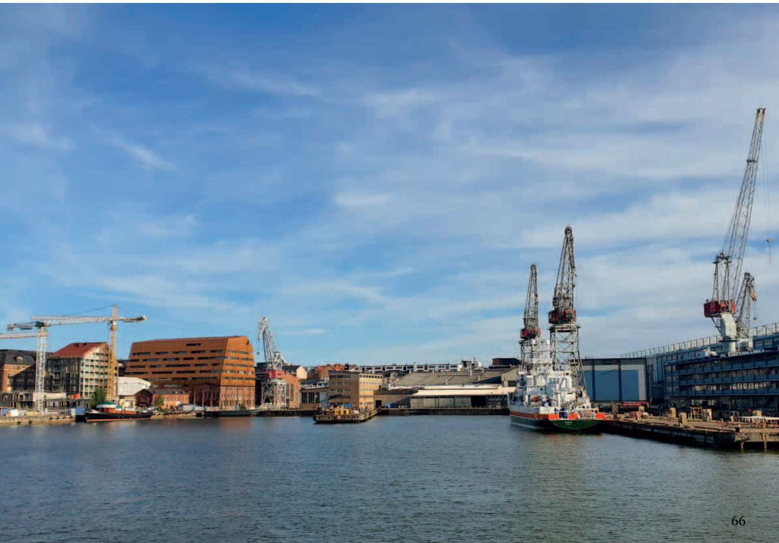
Kuva 95. Telakkarannan rakentumassa oleva alue on saanut jo uuden maamerkin uudesta Kemikaaliviraston rakennuksesta.
