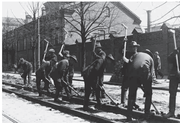
Kuva 65. Raitiotien rakentamista Sinebryhoffin panimoalueen kohdalla. Sähköisen raitiovaunureitistön rakentaminen vaati investointeja sekä sähköistyksen, että raiteiden osalta. Kuvassa vuodelta 1930 rakennetaan kiskoja Sinebryhoffin panimon kohdalla Bulevardilla. Kuvaaja Foto Roos, HKM.
