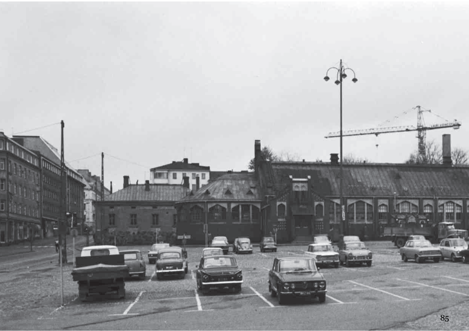
Kuva 131. Torin vanha valaisinmalli ja Hietalahdenkadun ristikkopylväät 1970-luvulla. Kuvassa näkyvät torin valaisimet on asennettu ennen vuotta 1943. Katso myös kuva 38, s. 34. Kuvaaja Eeva Rista, HKM.
