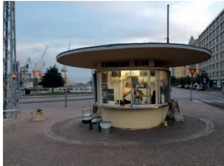
Kuva 45. Hietalahdentorin lippakioski on puurakententeinen, se on verhoiltu maalatulla kapealla rimalla ja sen lippa on rakennettu betonista. Kioski on säilynyt hyvin alkuperäisessä asussaan.
