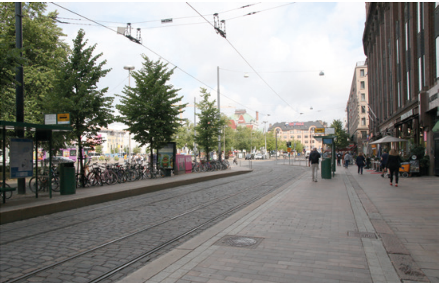
Mikonkadun ajorata ja jalkakäytävät on päällystetty kokonaisuudessaan luonnonkivellä, myös raitiovaunupysäkkien huomioraidat on ladottu valkoisesta luonnonkivestä. Päällysteiden yhtenäisyys edesauttaa viimeistellyn vaikutelman syntyä. Harmillisesti kalusteiden ja varusteiden kirjo peittää näkymiä kadulta Rautatien suuntaan.
