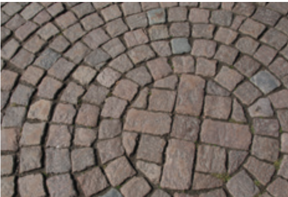
Kiveys on ladottu ympyrän muotoon kuten edeltänytkin kiveys 1939 uudistuksesta, joka korvasi aukiota alkujaan peittäneen kenttäkiveyksen.
