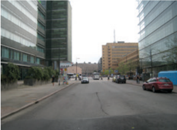
Ajokaistoja peittää pääosin asfalttipäällyste.
