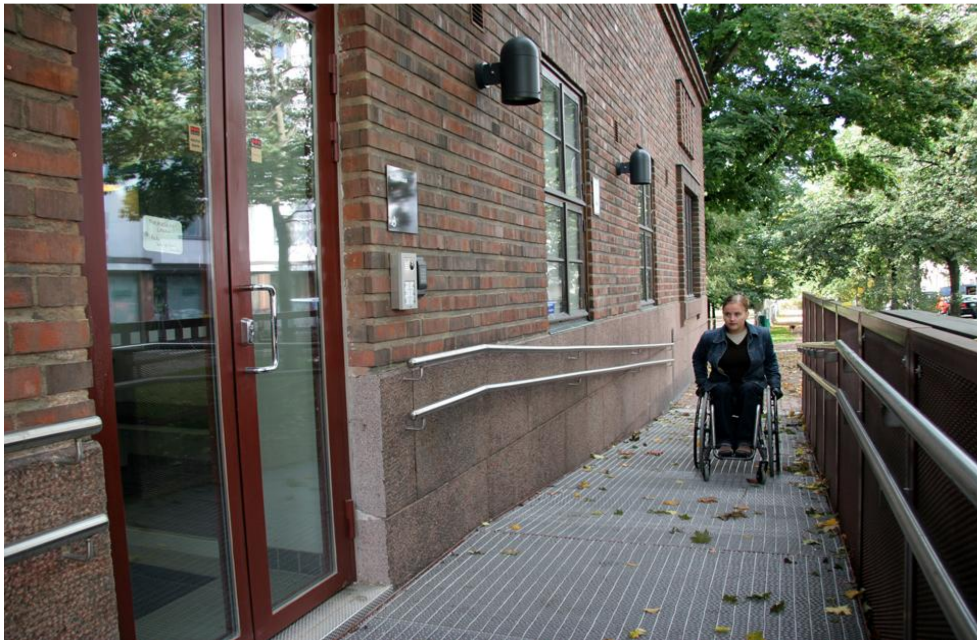
8. Rampen som leder till kyrkoentrén är i sträckmetall. Om rampens bredd är 1800 mm, kan två rullstolar mötas. (Agricolakyrkan)
