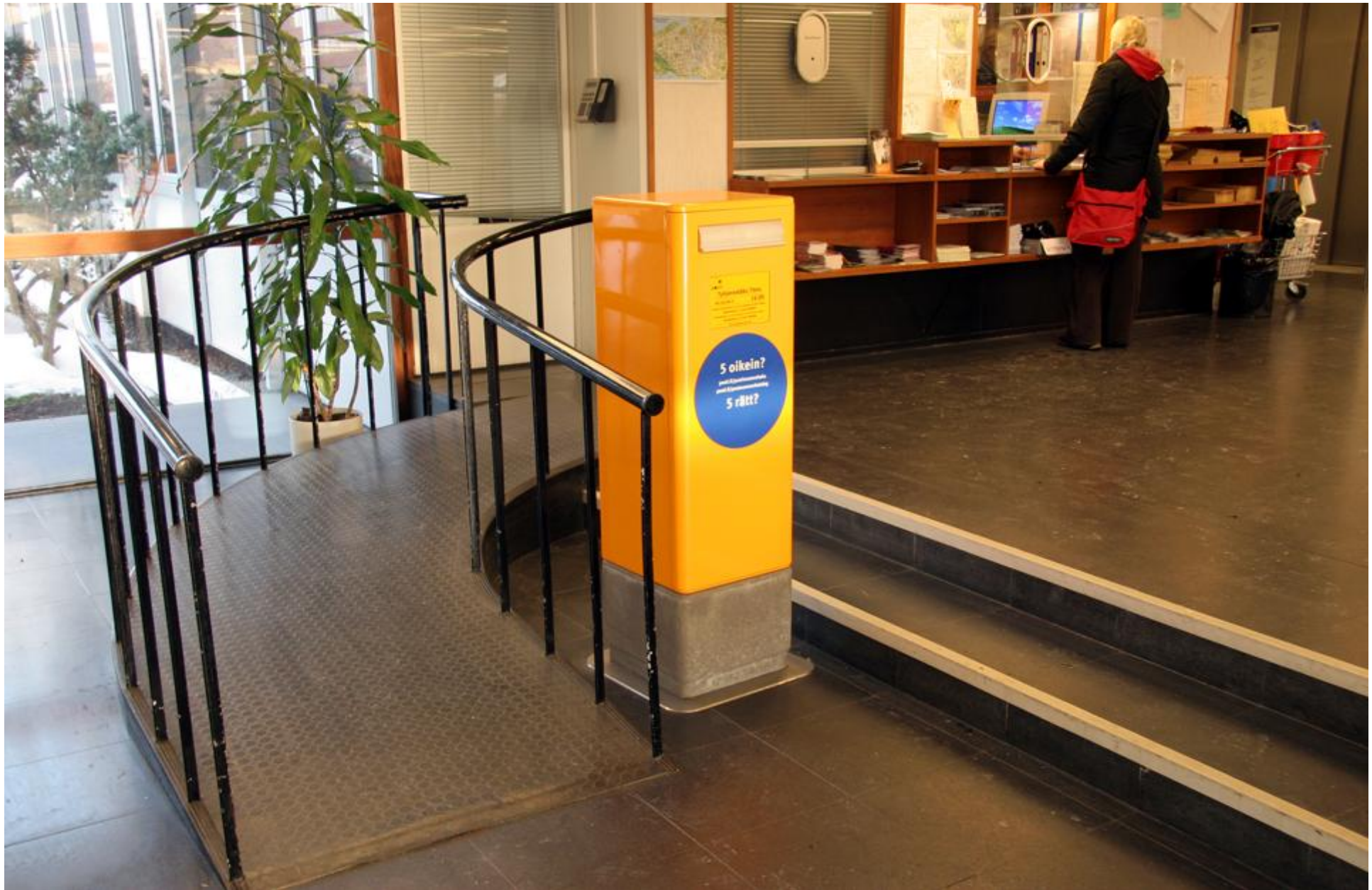
12. Denna branta kraftigt svängande ramp är mycket besvärlig att använda. (Tammerfors universitet)
