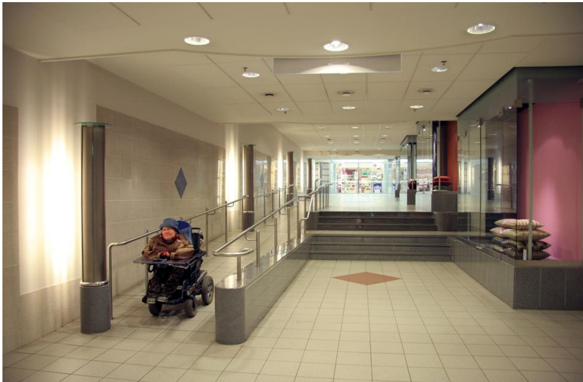
5. En ramp kräver mer utrymme än en trappa. En kort ramp skall vara minst 900 mm bred. (Förbindelsegången mellan Forum och Stockmann)
