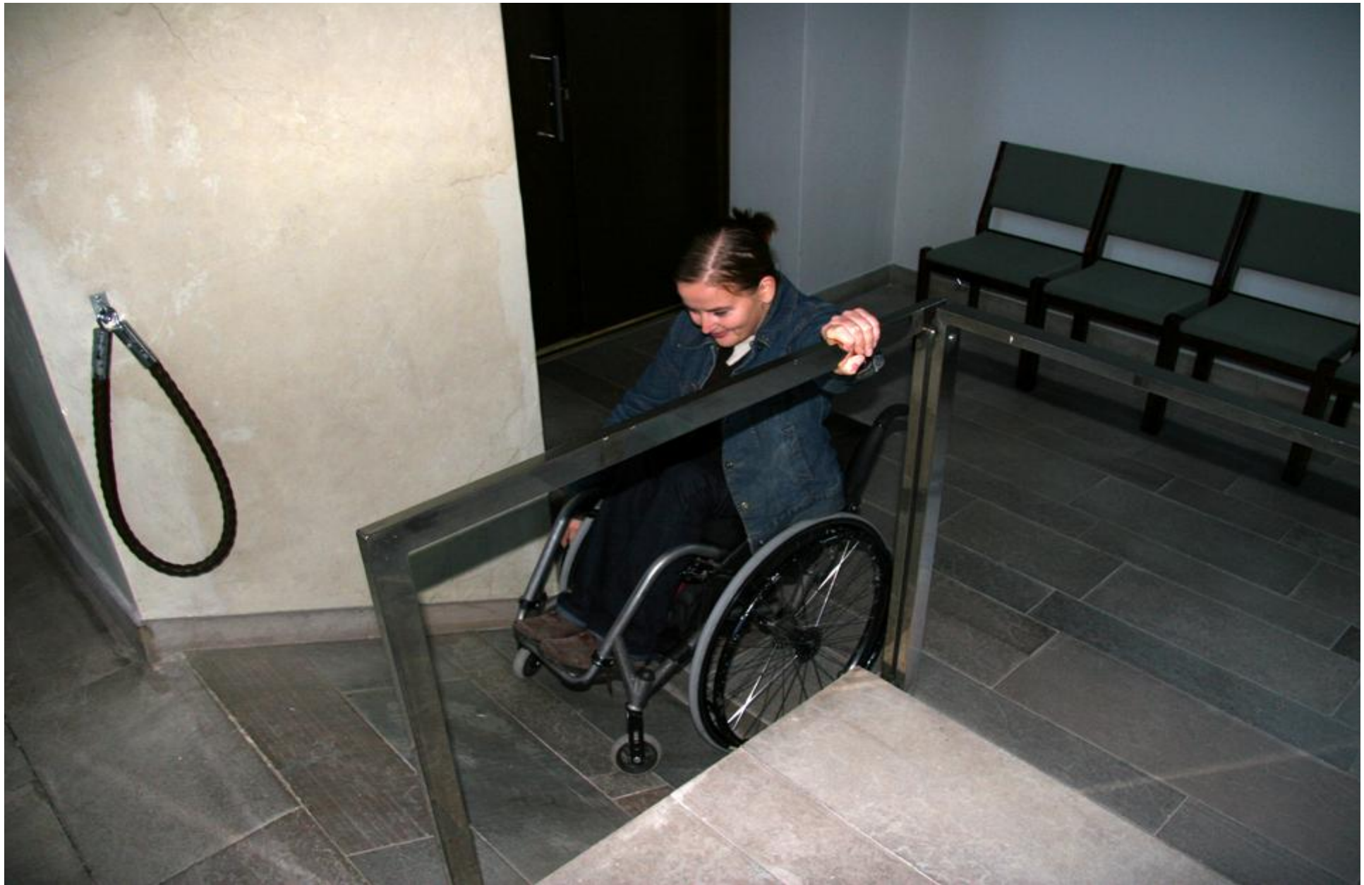
15. Alltid finns det inte utrymme för en ramp med rätt mått. Nivåskillnaden borde lösas med en lyftplatta istället för med denna obrukbara, alldeles för branta ramp. (Agricolakyrkan)
