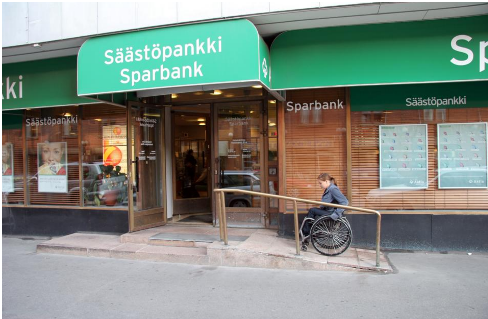
10. Denna ramp finns i skydd av en arkad. Rampen är onödigt brant trots att utrymme för en normenlig ramp skulle ha funnits. (Bergmangatan)
