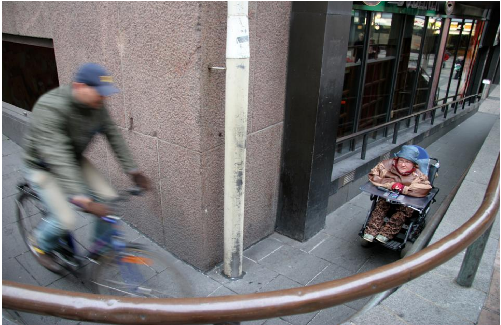
9. På denna ramp kan två rullstolar inte mötas. Situationen blir farlig p.g.a. att den andra ändan inte syns från rampens början. Det är nästan omöjligt att backa med rullstol utan hjälp. (Brunnsgården)
