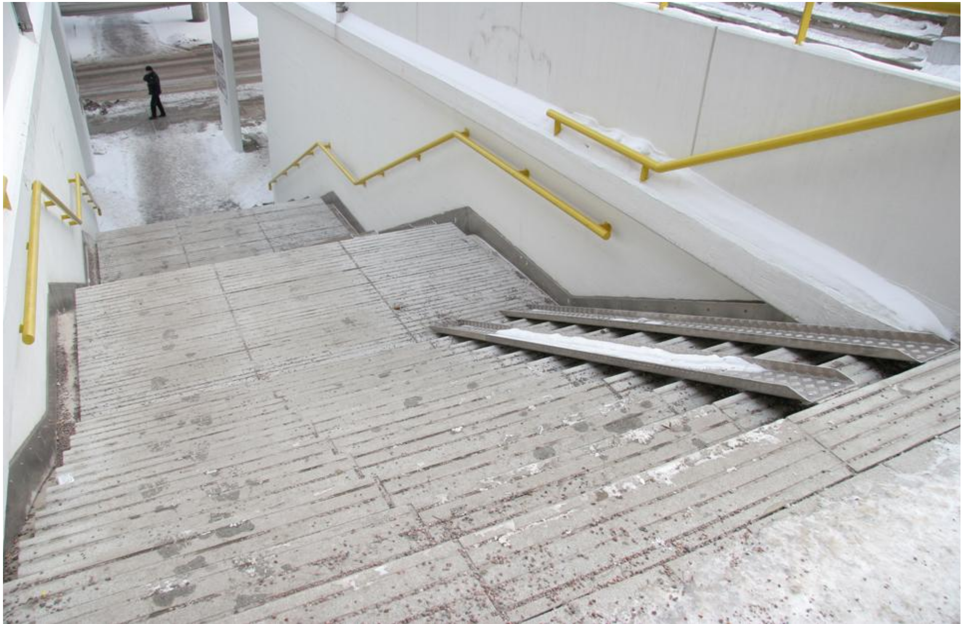
16. Skenorna i de branta trapporna är farliga och kan inte användas av rörelsehindrade personer. För synskadade personer innebär de risk för olycksfall. (Östra Böle)
