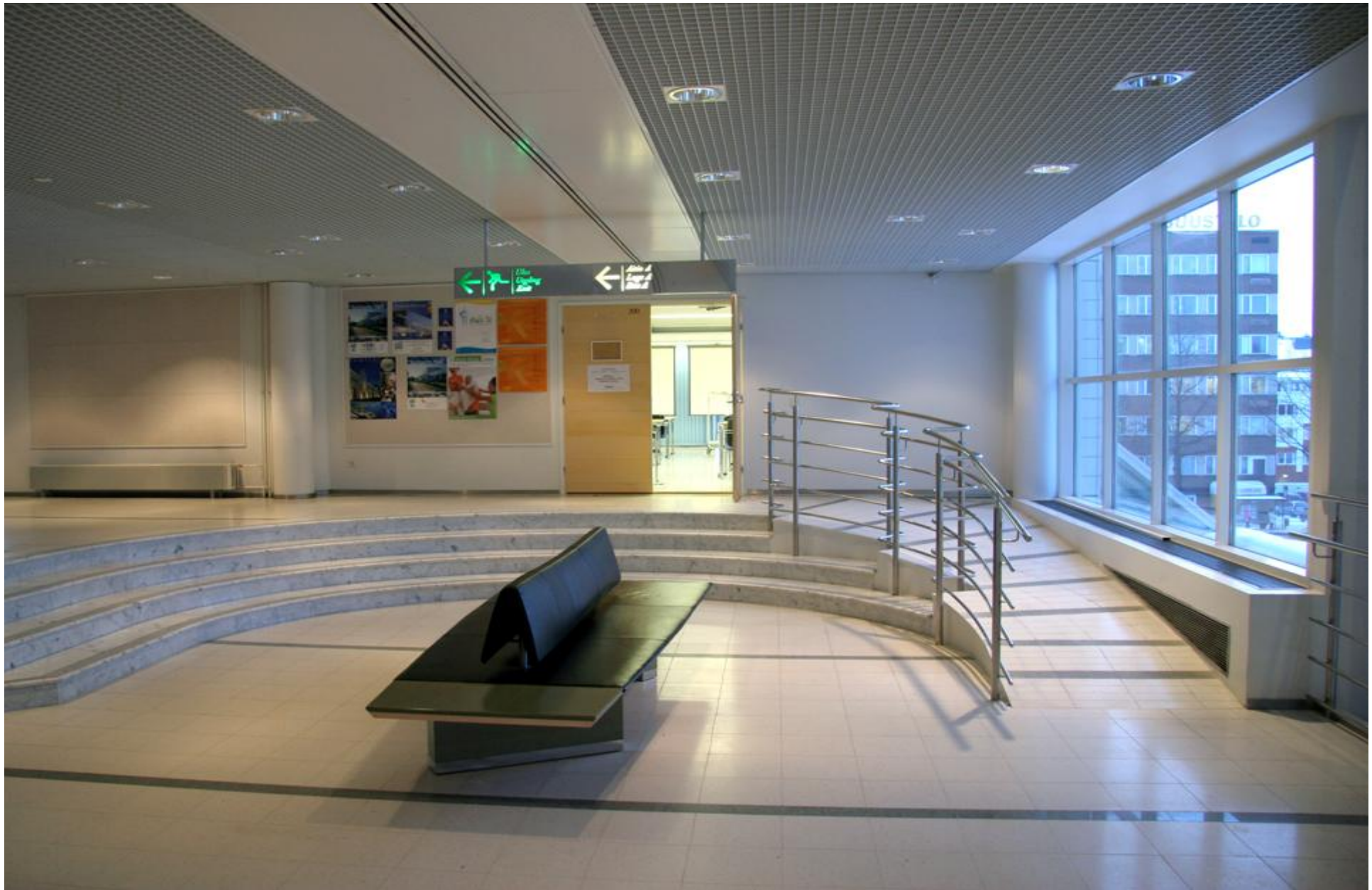
11. Rampen skall vara rak i färdriktning. På en svängd ramp måste riktnigen hela tiden korrigeras. (Tammerforshuset)
