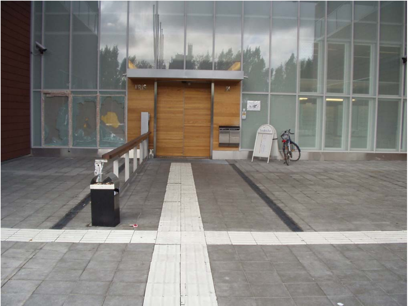
Kuva 6: Näkövammaisten Keskusliiton toimitalo Iriksen ympäristö on vaativaa erikoistason, jossa on erityisesti kiinnitetty huomiota näkövammaisten kulun ohjaukseen.
