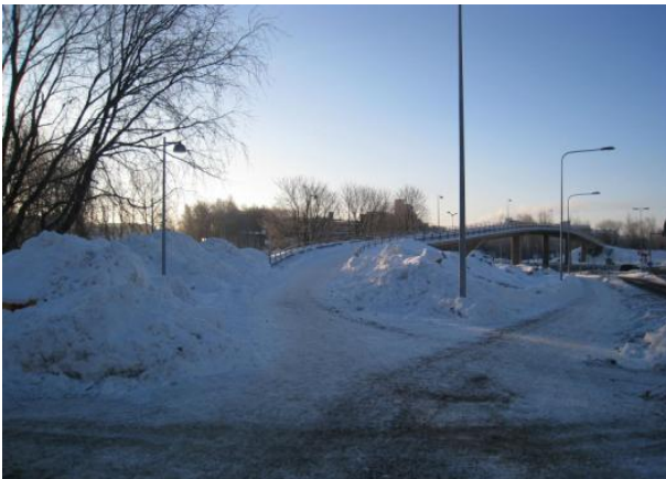
83. Kauppalantie 2, vanha Turunmaantien risteys, sillankaide
