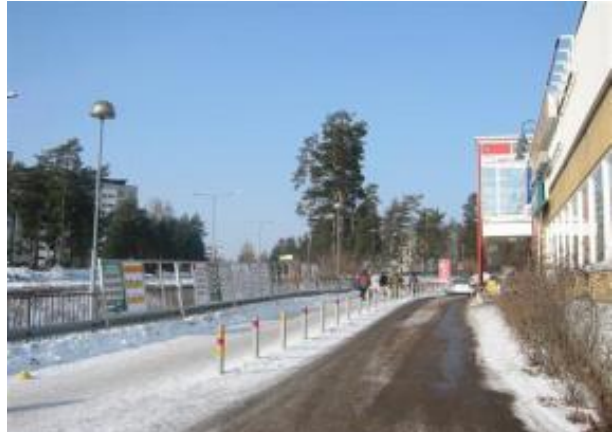
220. Kontulan ostoskeskuksen luona, alikulutunnelin aita
