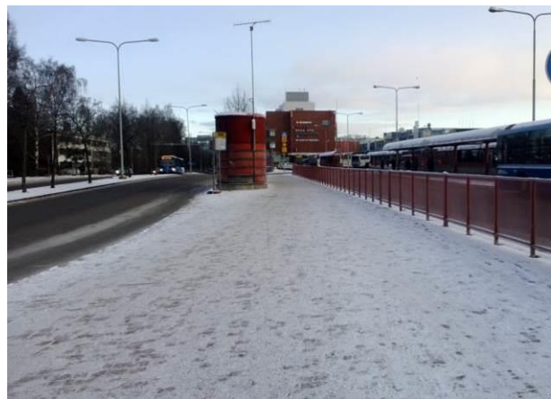
210. Itäkeskuksen metroasema, Turunlinnantien tallinnanaukio, pysäkin kohta, aita
