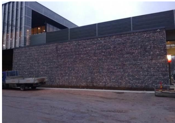
197. Siilitien metroasema, pysäkin kohta, seinän vierusta
