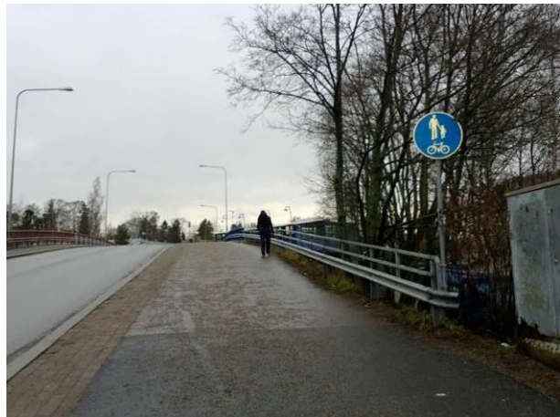
172. Tapanilan asema, Fallkullantie/ Jäkälätie, sillan kaide
