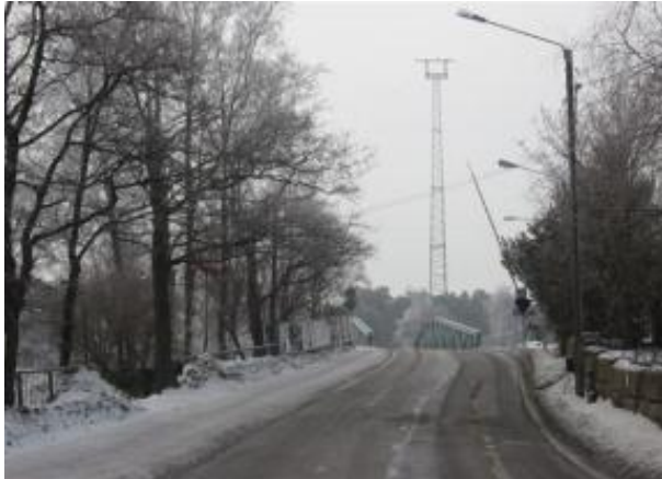
204. Hevossalmen silta, Santahaminaan johtavan sillan maatuen itäpuolen kaide
