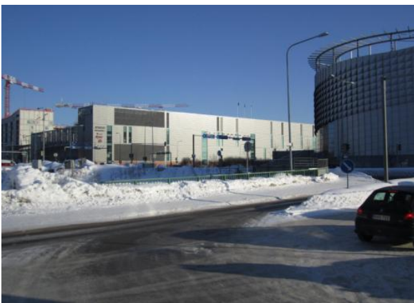
211. Turunlinnantie, Korsholmantien risteys, aita
