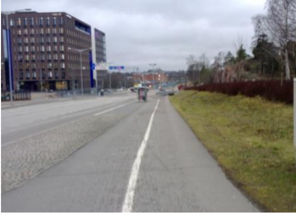
81. Hakamäentie /Kivihaantie, pysäkki, kevyenliikenteenväylän vierusta, nurmialue
