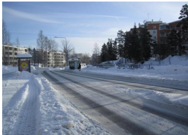
224. Rekipellontie, Luistarinkuja, sillan kaide pysäkin kohdalla
