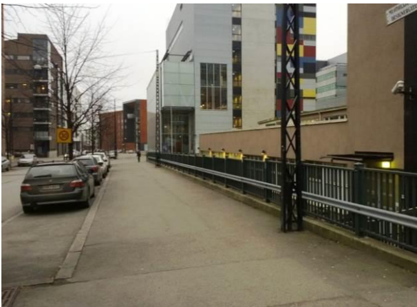
80. Muotoilijankatu 1, aita valaisinpylväiden väli
