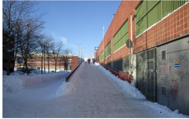
208. Asiakkaankatu 5, kävelysilta Itäväylän yli, parkkitalo, sillan kaide
