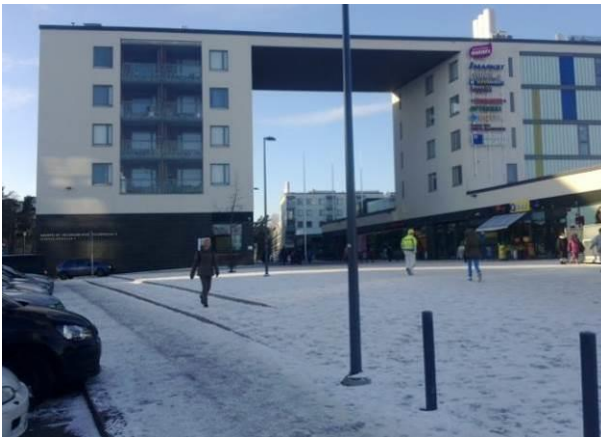
215. Kivensilmänkuja, jalkakäytävän reuna/ aukion laita valaisinpylvään linjassa, aukiolle päin
