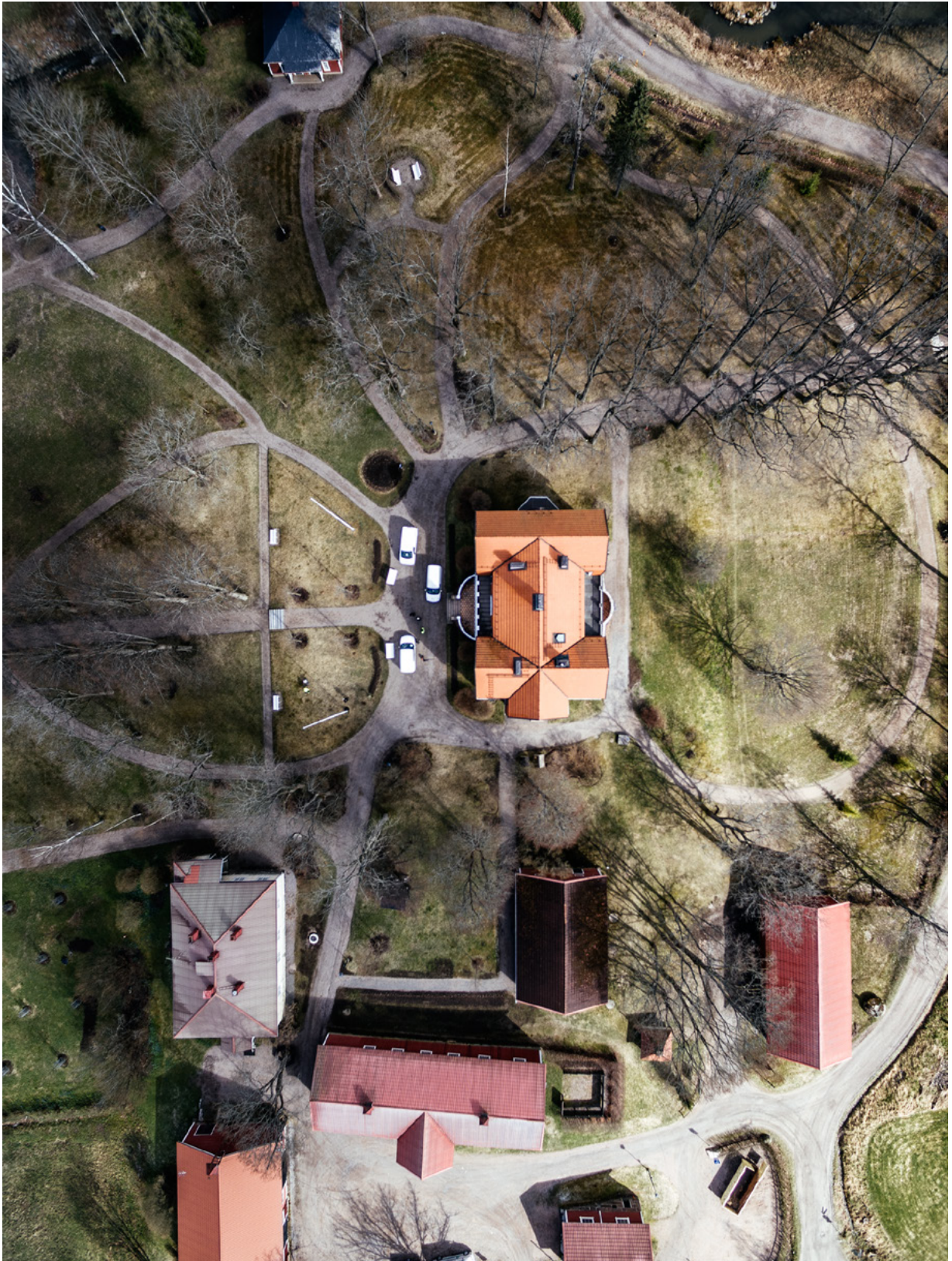
Keväisin ennen puiston suurien puiden lehvästöjä Häkansbölen kartanon puiston kaartuvat kujanteet näkyvät selvästi. Kesäisin tuuheat puut muodostavat varjoisia soppia. Pitkä tallirakennus erottaa tallipihan puistoalueesta. Kuva: Antti Yrjönen, Vantaan kaupunginmuseo.
