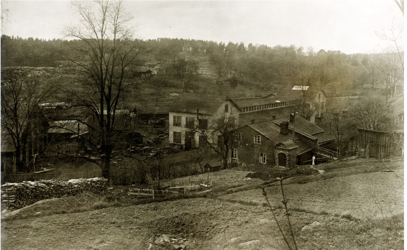
Kuvassa etualalla nykyisen Fiskarsin museopuutarhan alue 1900-luvun alkupuolella. Vanha tiilestä rakennettu sähkömuuntamo on myöhemmin purettu.
