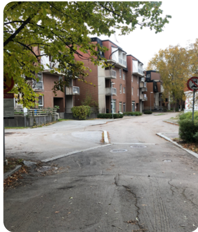
Kuva 88. Jägerhornintie, jäsentyvät kadun länsipää
