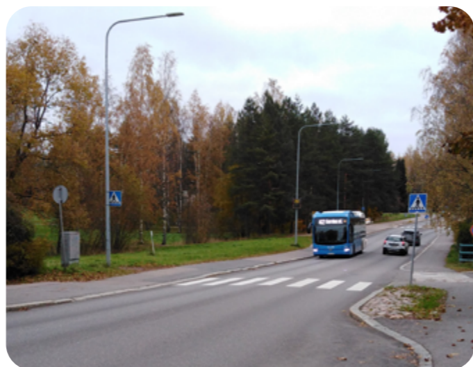
Kuva 70. Kanneltie punaisen luokituksen suojatie Runopolun liittymässä.
