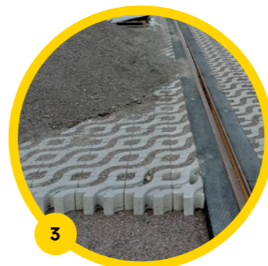
3 Vihreillä kivillä päällystetyt raitio- tieväylät (9,25 m 3 )
