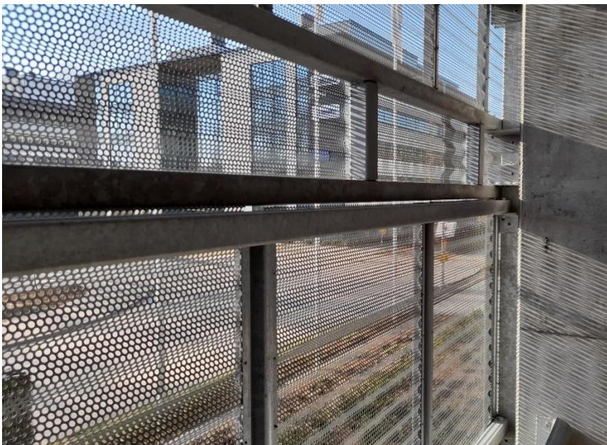
Kuva 2. Ramboll Villagen pysäköintitalon julkisivun pintana on käytetty rei'itettyä teräsohutlevyä.
