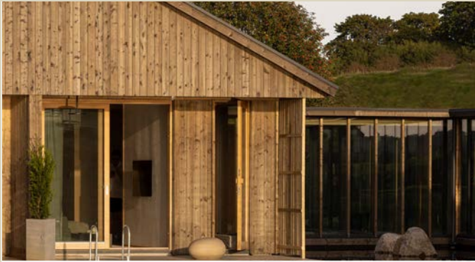
Laajennusosien julkisivu: Kuultokäsitelty puuverhous, tammen sävy
