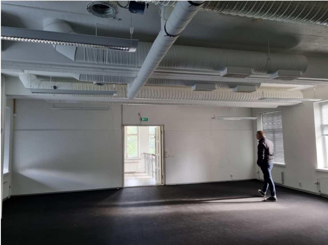
Tanssipaviljongin alakerran sali 2021 (rakennus tyhjillään)
