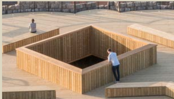
Terassirakenteet: Terassilaudoitus esim. Lehtikuusi tai lämpökäsitelty mänty
