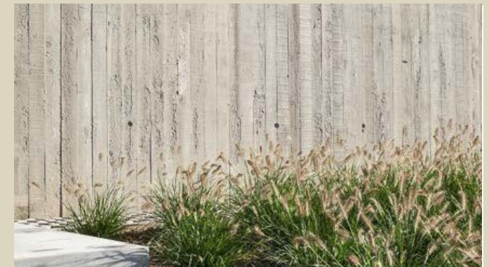
Sokkelipinnat: Betoni, harmaa esim lautamuottipinta
