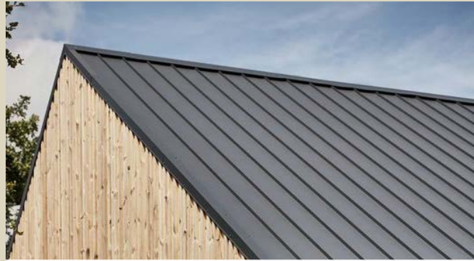
Vesikatto: Konesaumattu peltikate, musta
