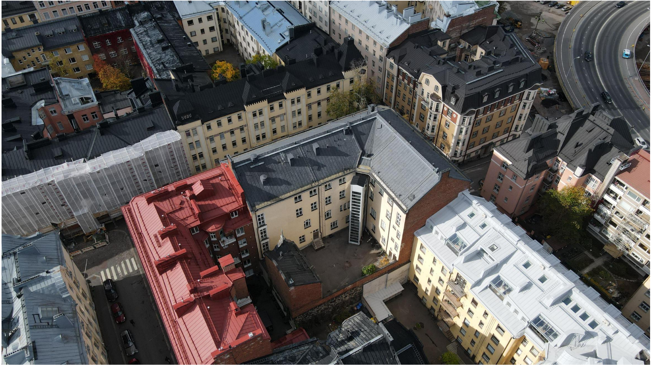
Ilmakuva sisäpihan puolelta (Kuva Heikki Hartiala / Aerial Nordic)
