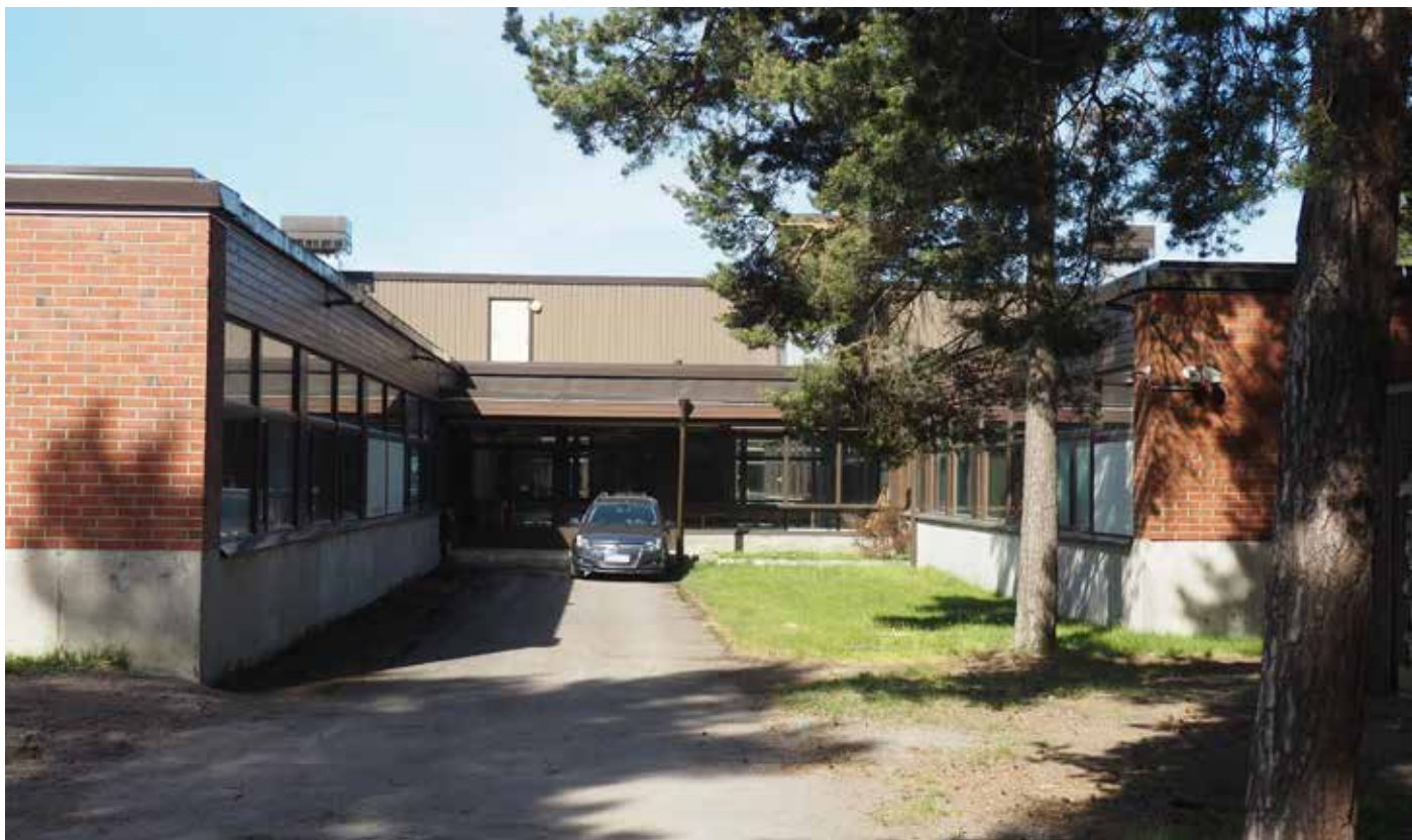
Aulatiloihin liittyvät ulkotilat jatkavat sisäpihojen sarjaa.
