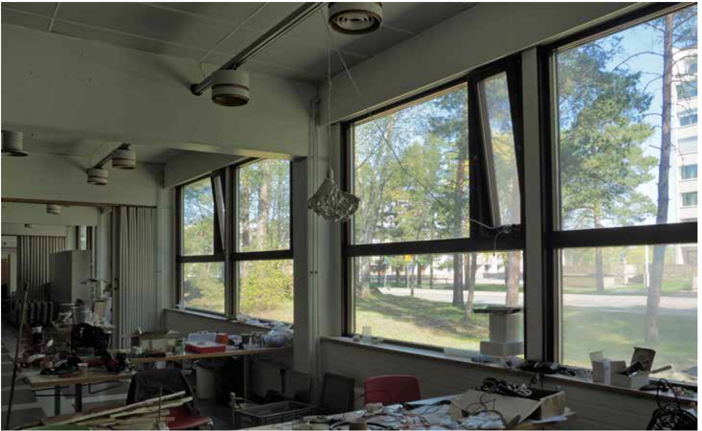
Tuuletusta tehostavat ikkunat ruokasalissa.
