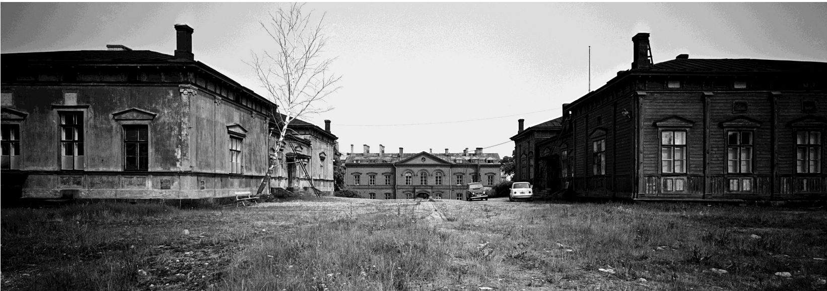
Vanhan Kätilöopiston pihaa (Tehtaankatu 1 - Neitsytpolku 11), purkutyöt käynnissä vuonna 1969. Valokuva: Kari Hakli. HKM
