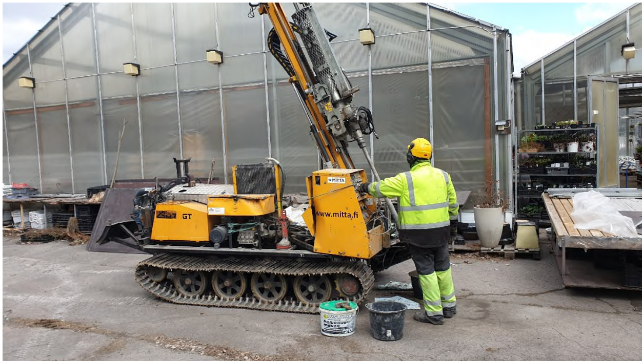
Kuva 3 Näytteenotto käynnissä näytepisteen EKO 5 kohdalla. Kuva otettu 3.5.2022.
