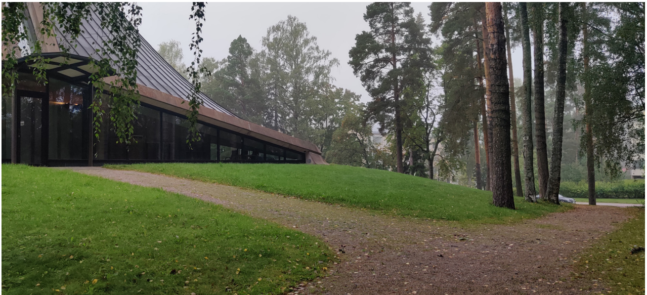
Kuva 2. Kannelmäen kirkon sivusisäänkäynnistä.
