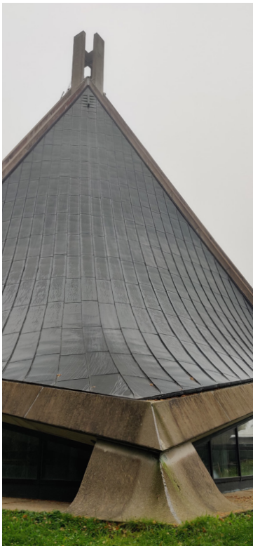
Kuva 3. Kirkkorakennuksen detalji ja kattopinta.
