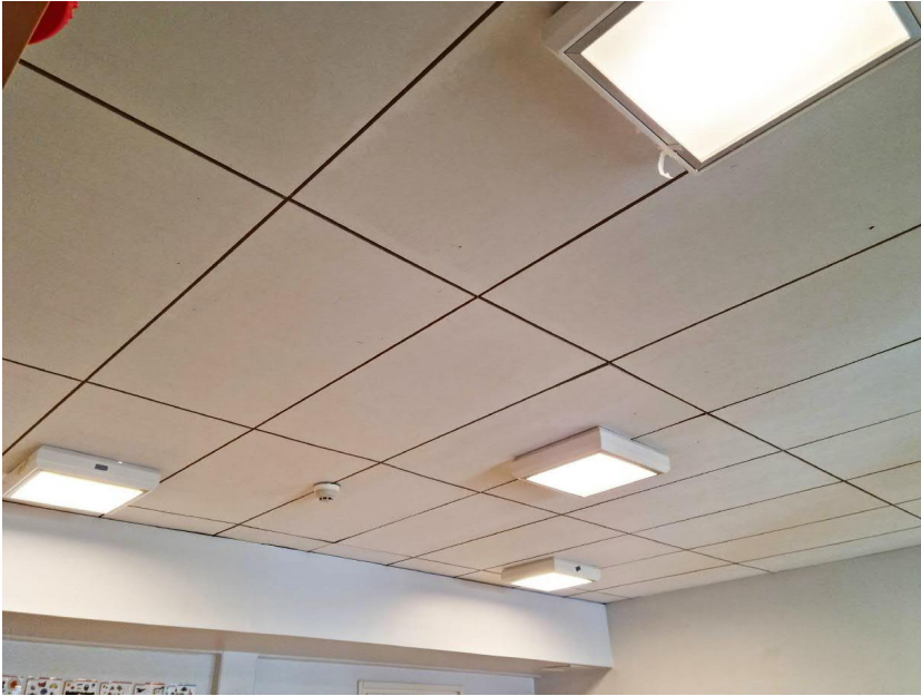
Päiväkodin yleinen sisäkatto, levyt avosaumalla.
