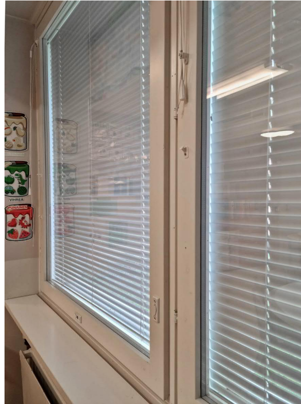
Ikkunat vaikuttavat alkuperäisiltä. Niihin liittyy rakennusajalle tyypillinen, säleiköllä varustettu kapea tuuletusikkuna. Sisäpuitteen eristyslasi on asennettu jälkikäteen.
