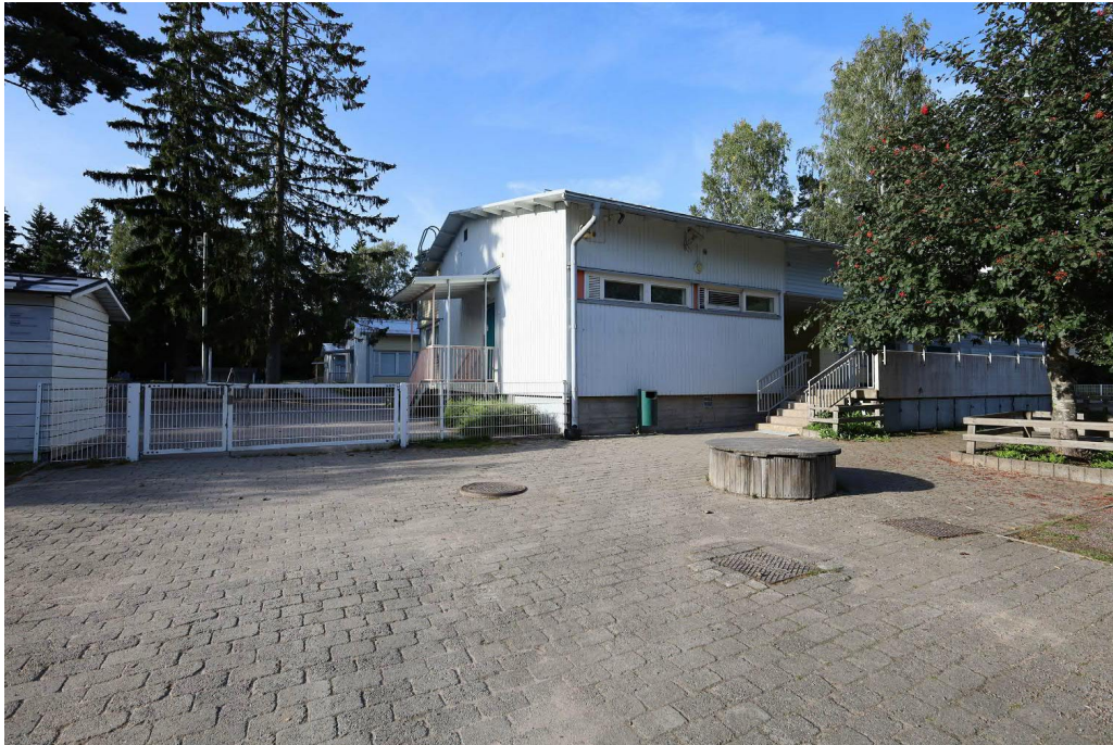
Kaakkoisjulkisivu Asukaspuiston piha-alueen suuntaan. Jyvävä terassi on varustettu uusilla portailla ja luiskalla.
