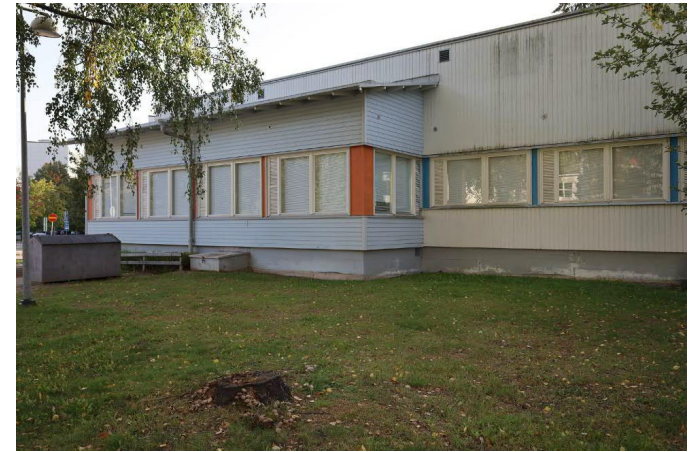
Koillisjulkisivun osa. Vaaleiden pastellisävyjen lisäksi 1990-luvun muutostyössä käytettiin korostusvärejä vaneripinnoissa.
