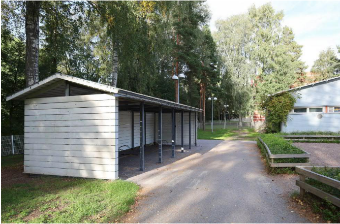
Uusi pihakatos on rakennettu vuoden 2003 jälkeen.
