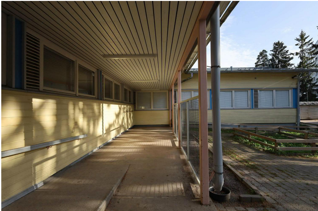
Lounaaseen avautuvat, paviljonkien ja yhdyssiipien rajaamat piha-alueet ovat ilmeeltään lähempänä alkuperäistä ilmettä kuin muut julkisivut, lukuun ottamatta leveitä räystäitä, vaakalaudoitusta ja julkisivuväritystä. Kahden pihan julkisivuvärit vaihtelevat, eteläisempi on vaaleankeltainen, pohjoisempi vaalean siniharmaa.
