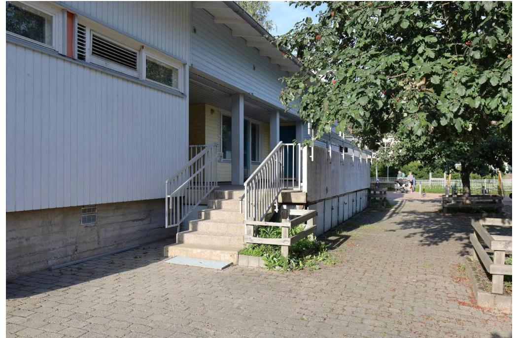
Terassin portaat ja kaitteet ovat 1990-luvulta. Kuvassa näkyy hyvin, miten ulkoseinä on kasvanut ulos päin vanhan ulkoseinän lisäeristeen ja uuden julkisiiverhouksen 100 mm:n koolauksen verran. Vanha betonisokkeli lauta-muottikuvioineen on säilynyt.
