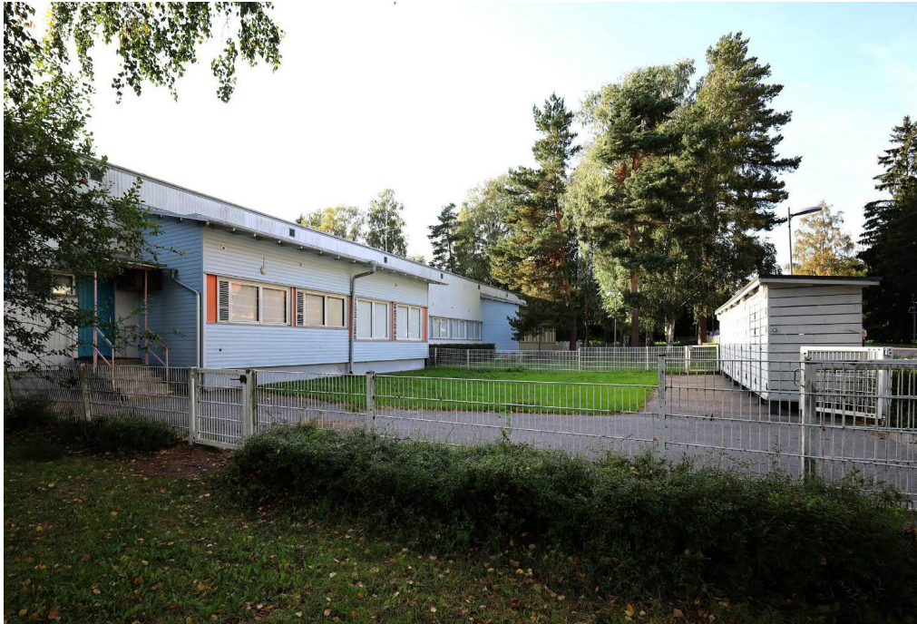
Emännänpolun puoleinen piha-alue on laajentunut entisen puistokaistaleen puolelle. Pihakatos on 2000-luvulta.
