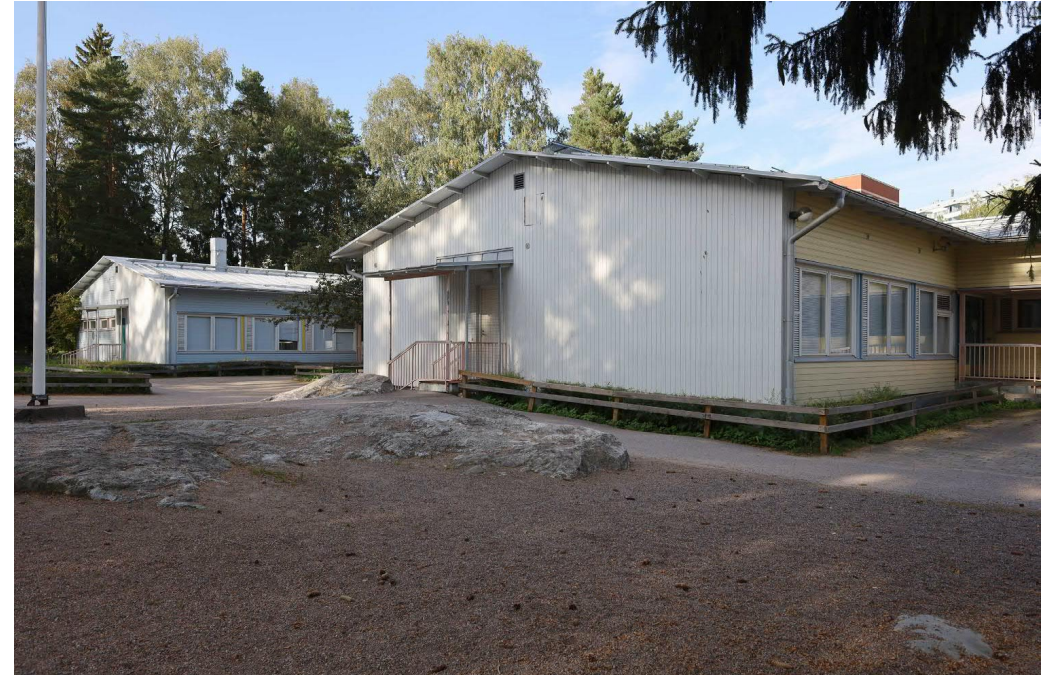
A- ja C-paviljonkien päätyjulkisivuissa näkyy loiva satulakatto ja vaalea pysty- laudoitus 1990-luvulta.
