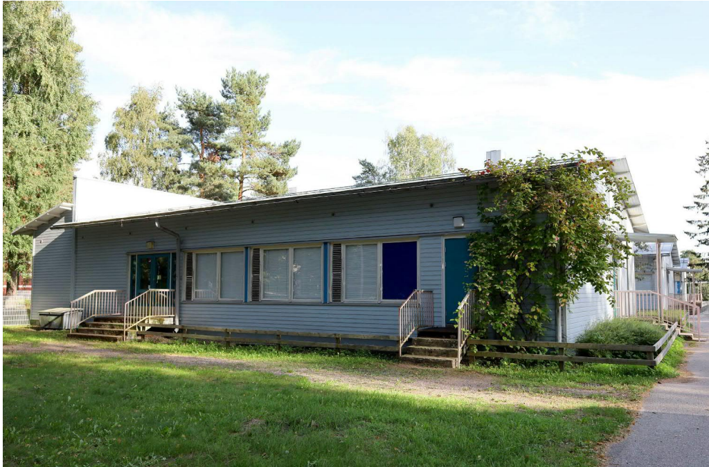
A-osan lastentarhilojen julkisivu luoteeseen. Korotus, loiva satulakatto, leveä räystääs, syöksytorvet, uusi julkisivuverhoaus, vaakalaudoitus, sekä uusi väritys periytyvät vuoden 1996 muutostöistä. Nauhaikkunoissa on alkupe- räinen jako ja sivuille sijoitetut tuuletusluukut.
