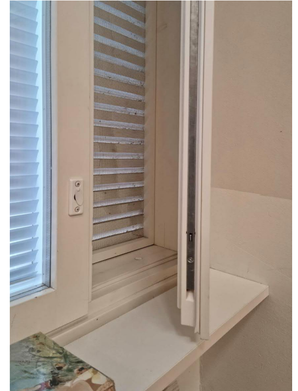
Ikkunat vaikuttavat alkuperäisiltä. Niihin liittyy rakennusajalle tyypillinen, säleiköllä varustettu kapea tuuletusikkuna. Sisäpuitteen eristyslasi on asennettu jälkikäteen.
