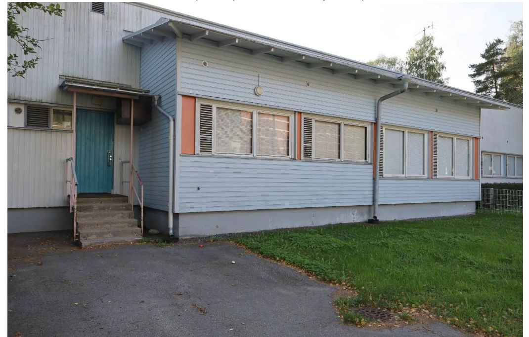
C-paviljongin pääty koilliseen on korotettu ja varustettu pulpettikatolla.
