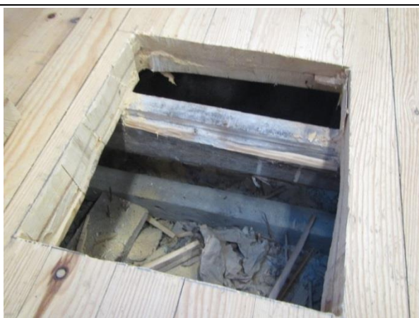
Kuva 8. Rakenneavaus RAK VP11
