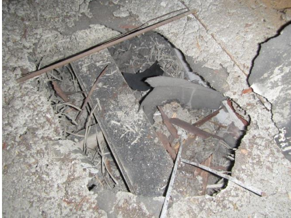
Kuva 9. Yläpohjan rakennekerrokset tarkastettiin palopermannossa olleesta reiästä
