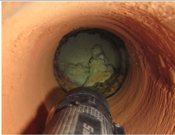
Kuva 3. Rakenneavaus RAK US1
