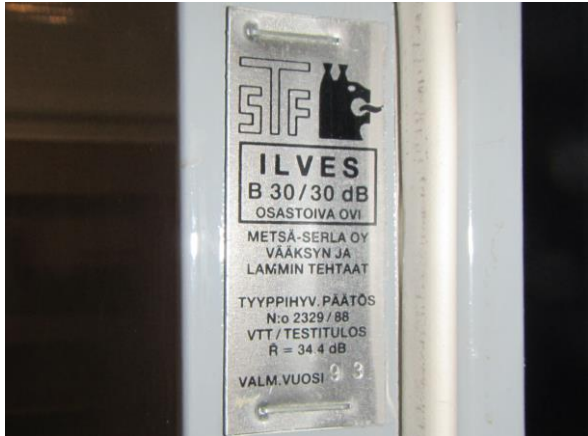
Kuva 11. Todennäköisesti palo-ovi PO3 ei sisällä asbestia.
