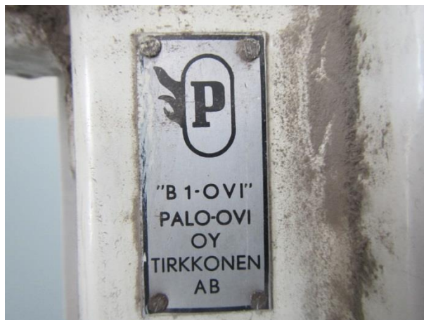
Kuva 10. Palo-ovi PO1 saattaa sisältää asbestia.
