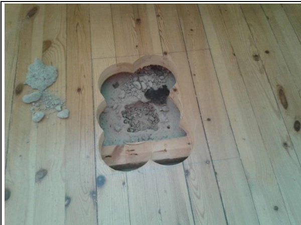
Kuva 2. Rakenneavaus RAK AP1.2016
