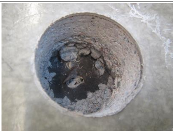
Kuva 7. Rakenneavaus RAK VP4
