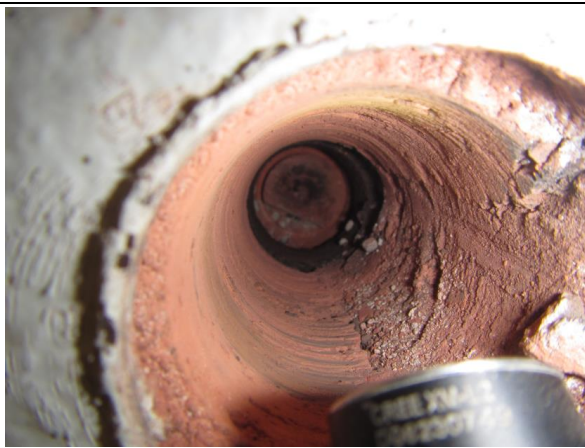
Kuva 4. Rakenneavaus RAK US4
