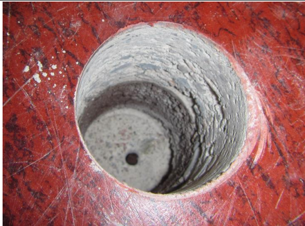
Kuva 6. Rakenneavaus RAK VP3
