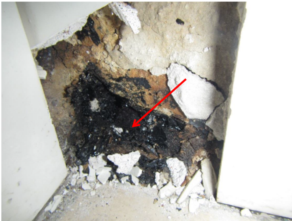
Kuva 12. Märkätilan bitumisively Musiikkiopistossa sisältää asbestia (antofylliitti). (Näyte WMY 50)
