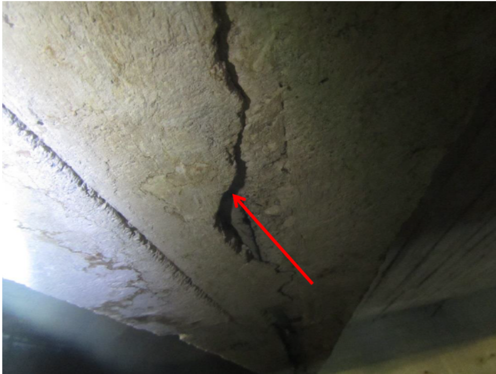
Kuva 11. Liikuntasaunan bitumikermi sisältää asbestia (antofylliitti). (Näyte WMY 42)
