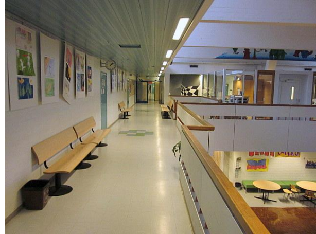
Kuva 12 Asbestitonta Hovi-vinyylilaattaa oli käytetty runsaasti koulun latti-oissa.
