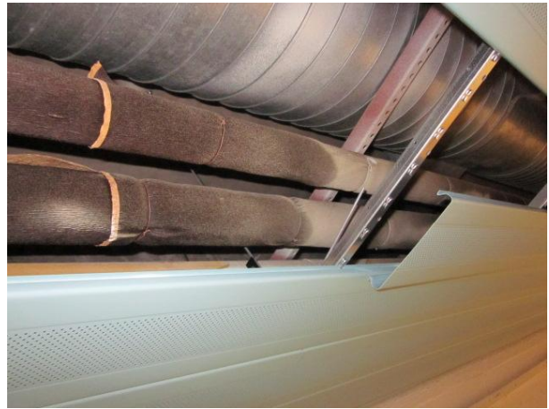
Kuva 2 Alakattotiloissa olevat putket olivat mineraalivillaa jonka päällä oli tervapaperi.
