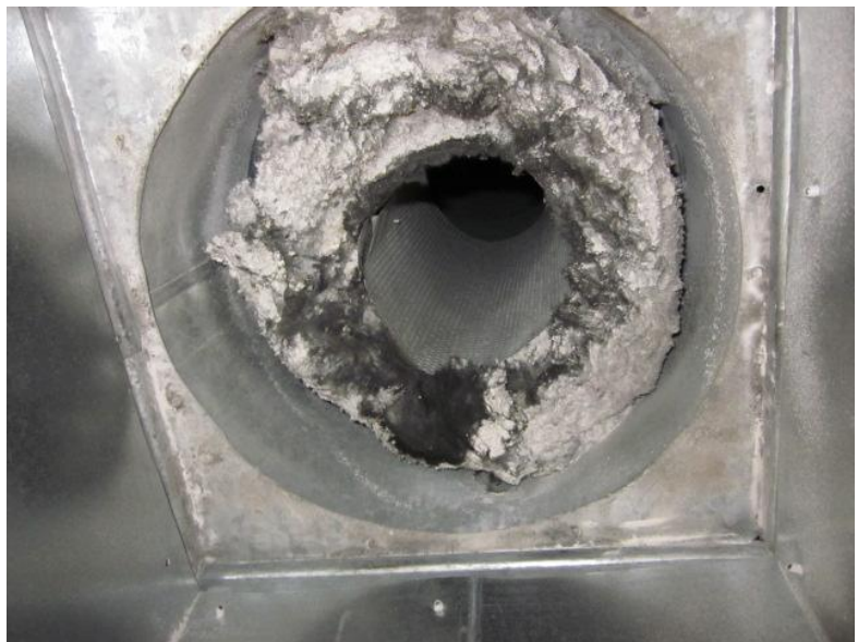
Kuva 10 Kuvassa olevan Iv-kanavan eriste on mineraalivillaa jonka päällä on vaaleaa tavallista pölyä.
