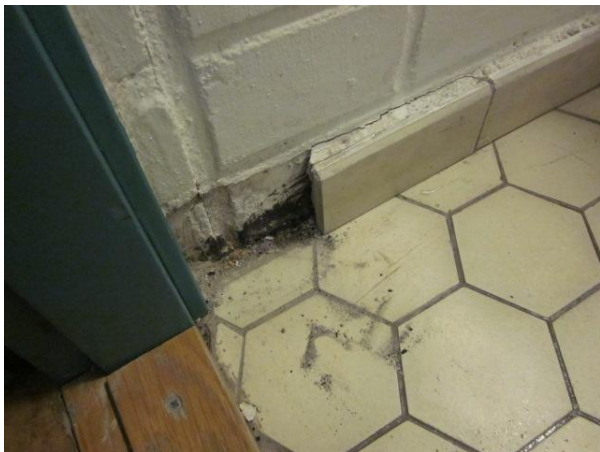
Kuva 5 Näytteet 3 ja 4. kuusikulmaisissa lattialaatoituksissa ja vesieristekelmässä havaittiin asbestia.
