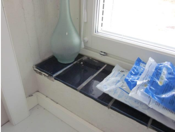
Kuva 7 Näyte 5. Keraamisissa ikkunalaatoituksissa ei havaittu asbestia.
