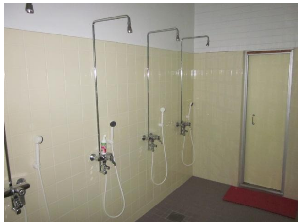
Kuva 6 Kohteessa oli uusittu laatoituksia monin paikoin.
