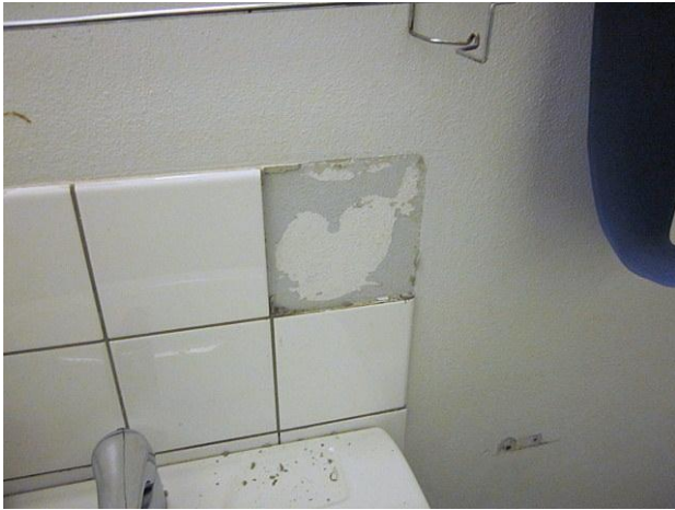
Kuva 3 Näyte 2. Pyöreäreunaiset seinälaatoitukset sisälsivät asbestia.
