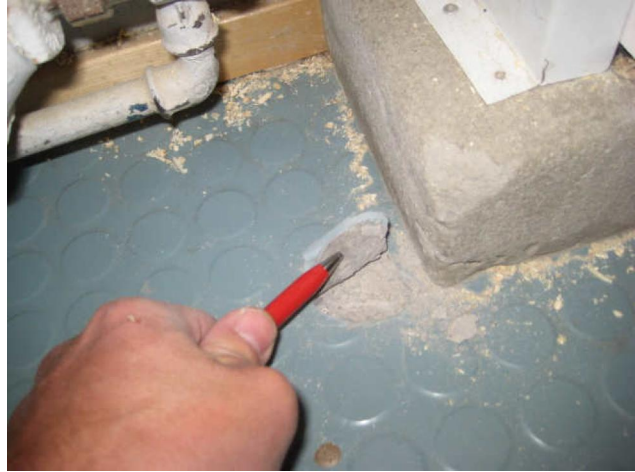
Kuva 8 Muovimattojen alla ei havaittu haitallisia aineita.
