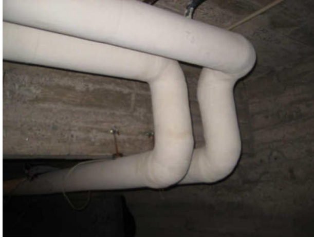
Kuva 3 Alapohjatilassa olevat putket eivät sisältäneet asbestia.
