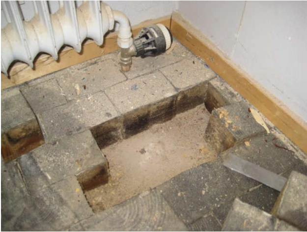
Kuva 7 Puutyöluokan konehuone. Lattia-pölkkyissä ja betonilattian pinnassa oli PAH-yhdisteitä.
