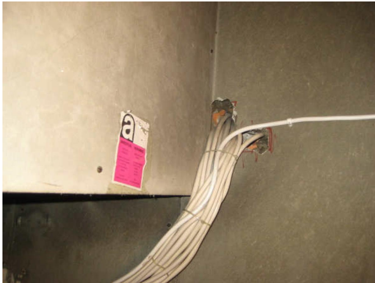
Kuva 3 Alapohjatilassa olevat putket eivät sisältäneet asbestia.
