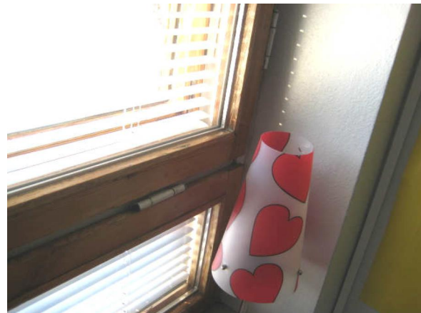
Kuva 10 Umpilasiniikkunoita. Mikäli lasit ovat vuodelta 1979 tai vanhempia tulee niiden mahdollinen PCB-pitoisuus selvittää ennen purkamista.
