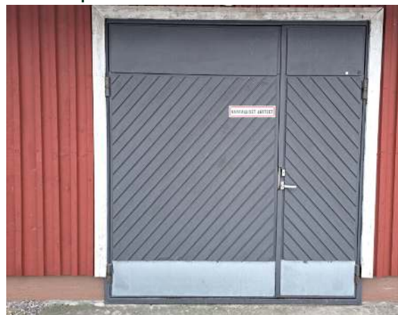
97. Eläinsuojan/maneesin O37 ulko-ovi.
