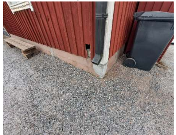
6. Lampolan O35 vierustaa ja kattovesien ohjausta.
