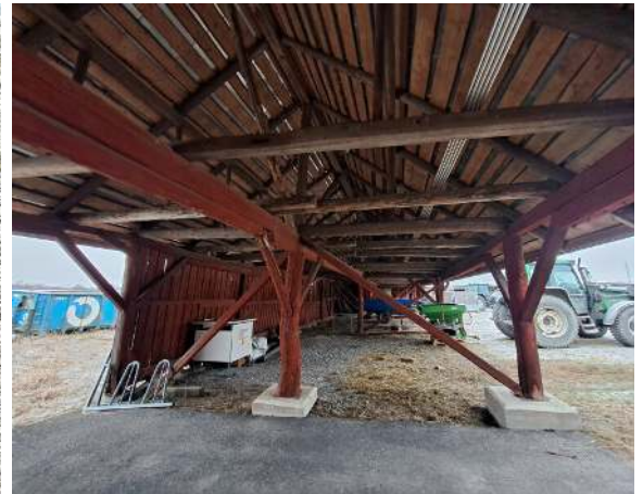
54. Katoksen O20 runkorakenteita.
