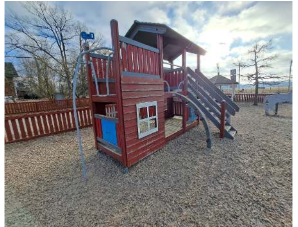
15. Leikkivälineissä on havaittavissa pinnan kulumaa.
