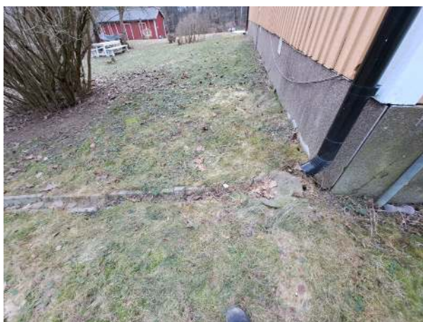
1. Asuinrakennuksen O10 (keltainen talo) vierustaa ja kattovesien ohjausta.
