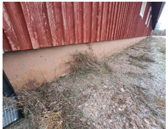
31. Eläinsuojan/maneesin O37 sokkeleissa ei havaittu merkittäviä vaurioita.
