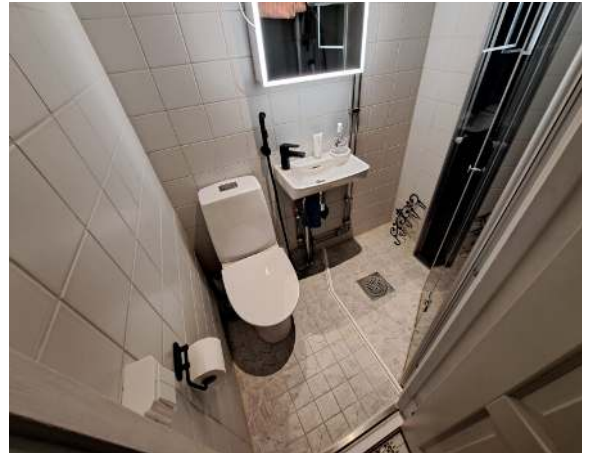
133. Asuinrakennuksen O10 B-asunnon kylpyhuone on uusittu.
