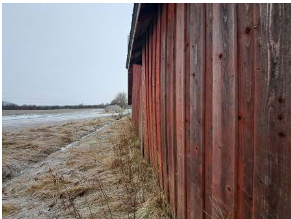
67. Verstas/katos O19 julkisivuverhoukus on taipunut.
