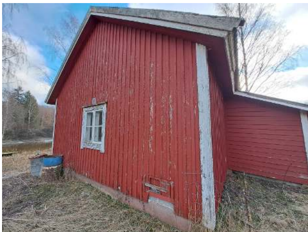
61. Saunarakennuksen O17 julkisivua.
