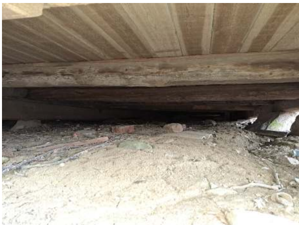
42. Talousrakennuksen puurakenteinen alapohja.
