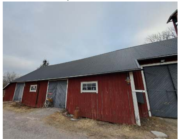
115. Keskusvaraston O31 vesikattoa.
