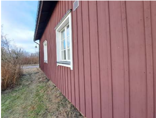
57. Asuinrakennuksen O12 julkisivua.
