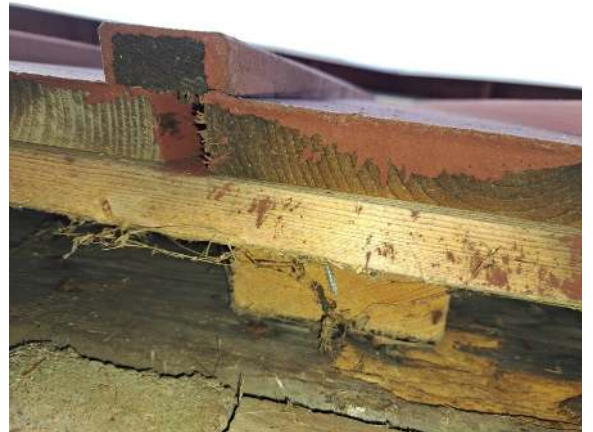
58. Asuinrakennuksen O12 julkisivuverhouksen takana on tuuletusrako.
