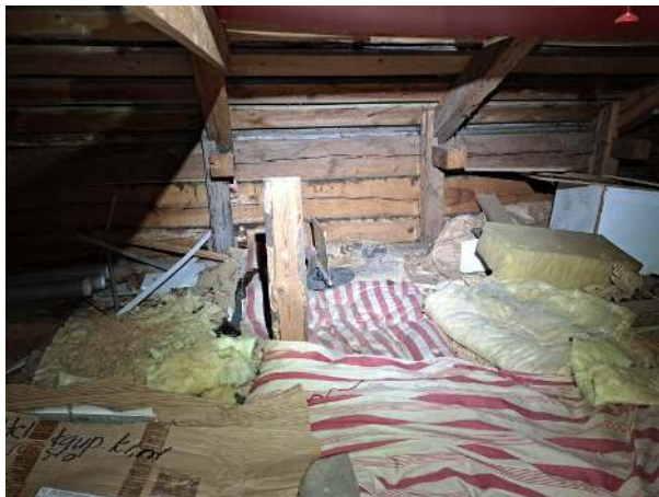
43. Asuinrakennuksen O10 hirsirakenteinen ulkoseinä.
