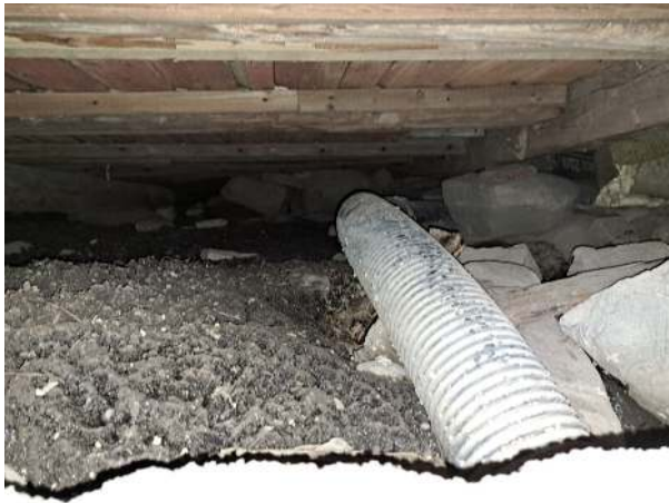
38. Kuvaa asuinrakennuksen O12 alapohjatilasta.
