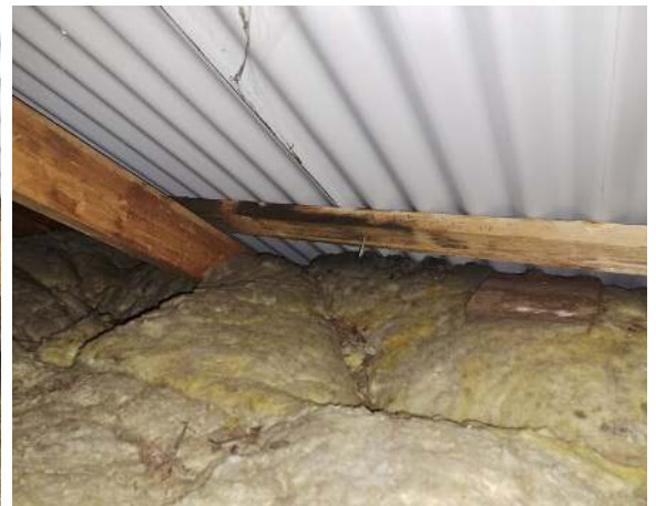
109. Asuinrakennuksen O12 yläpohjatilassa tehtyjen havaintojen mukaan vinokatto-osuuksilla lämmöneriste on kiinni vesikatteessa.
