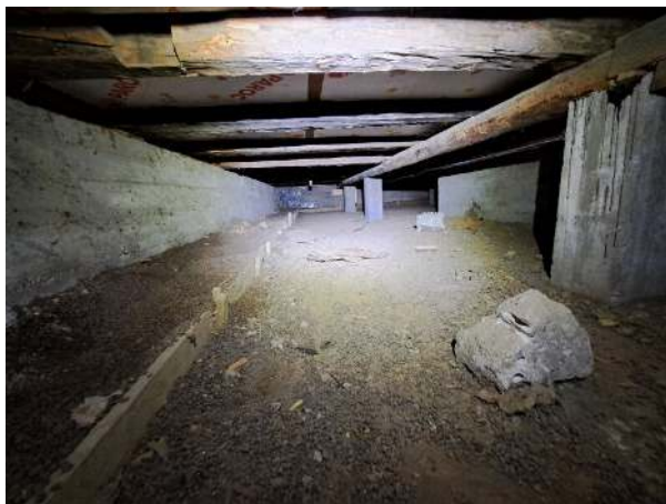
36. Asuinrakennuksen O10 alapohjatilaa.
