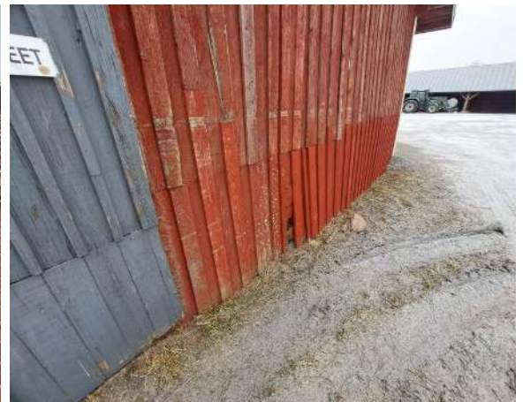
66. Verstas/katos O19 julkisivuverhousten alaosia on uusittu.
