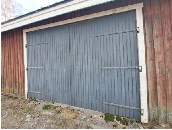
100. Kuusiladon O30 pariovet ovat havaintojen mukaan uusittu.
