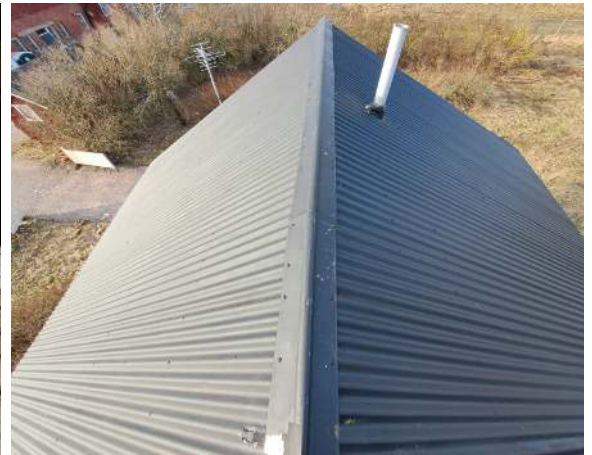
107. Asuinrakennuksen O12 vesikattoa.
