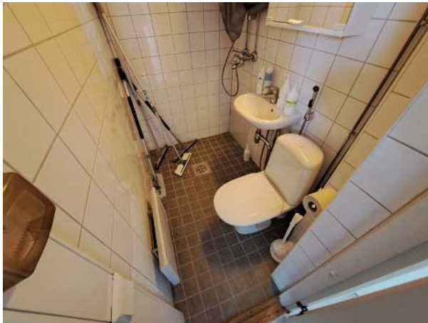
134. Asuinrakennuksen O12 kylpyhuoneet on saneerattu.
