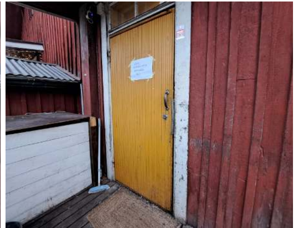
89. Ravintolarakennuksen O11 ulko-ovi.
