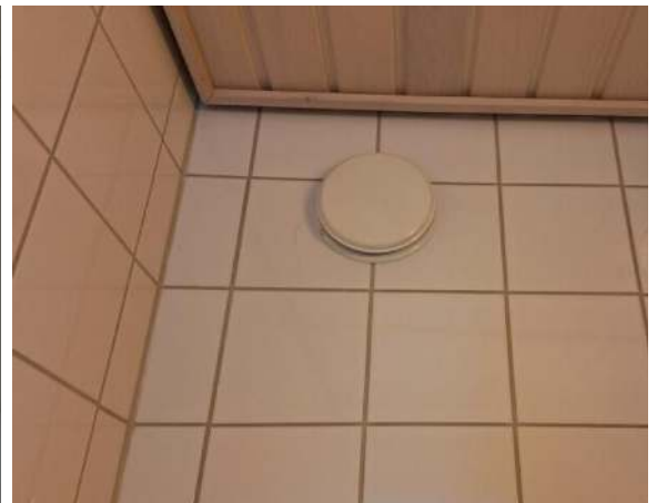
162. Poistoilmaventtiili O12 B.
