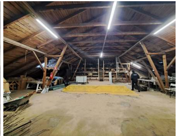
56. Lampolan O35 runkorakenteita.
