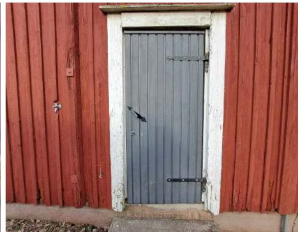
91. Saunarakennuksen O17 uusittu ulko-ovi.
