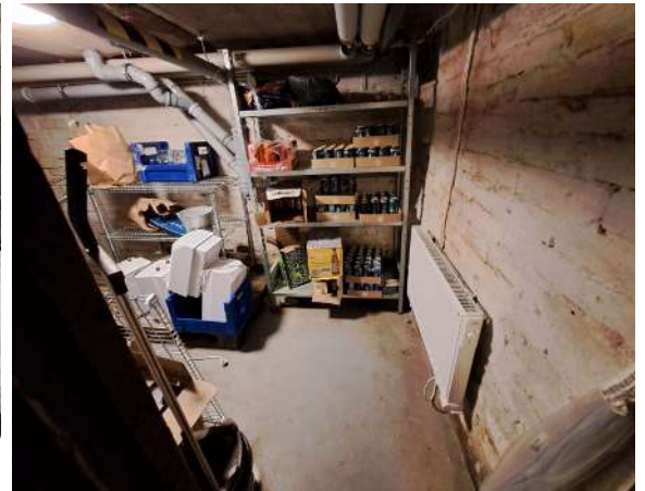
39. Ravintolarakennuksen O11 kellarin maanvastainen alapohjarakenne.
