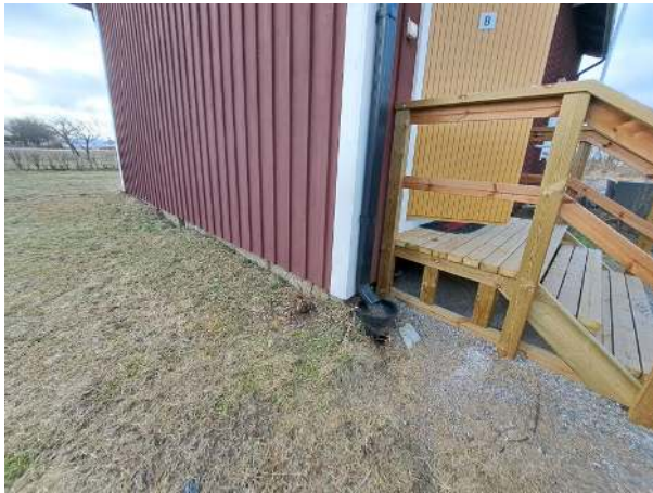
3. Asuinrakennuksen O12 vierustaa ja kattovesien ohjausta.
