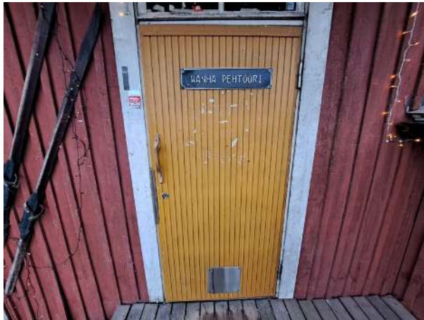
88. Ravintolarakennuksen O11 ulko-ovi.
