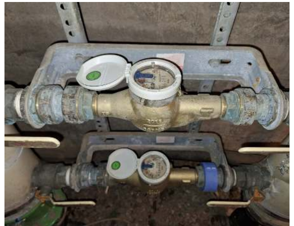
140. Kiinteistön vesimittarit.
