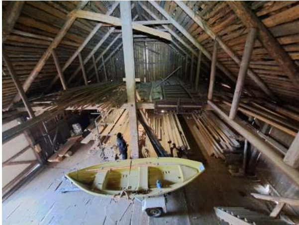
51. Kuusiladon O30 runkoa, kattokannattajien tukilauta on irronnut.
