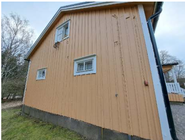
59. Asuinrakennuksen O10 julkisivua.
