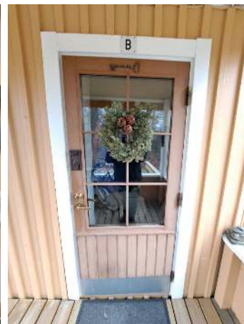
87. Asuinrakennuksen O10 ulko-ovi
