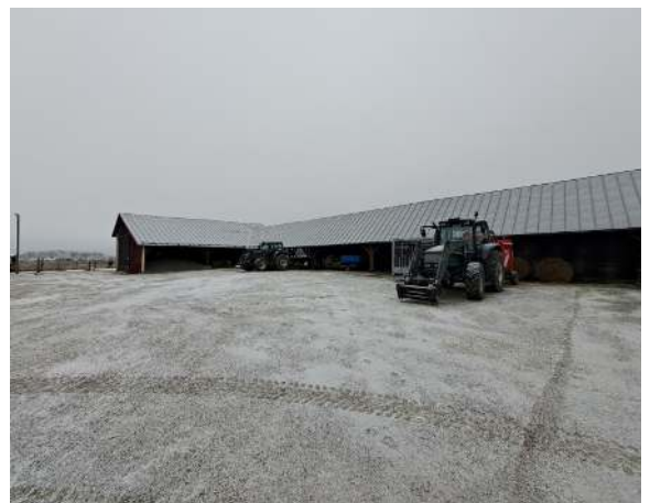
117. Verstaan/katoksen O19 vesikattoa.
