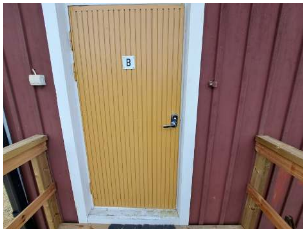
90. Asuinrakennuksen O12 ulko-ovi.
