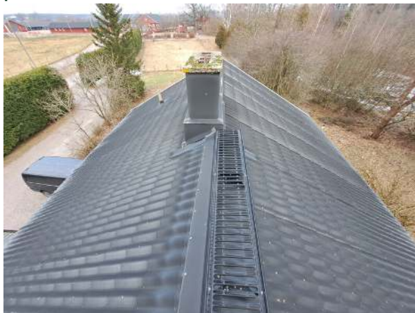
104. Asuinrakennuksen O10 vesikattoa.
