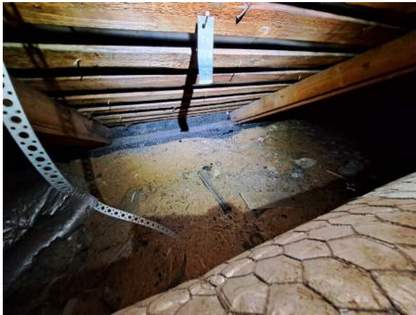
106. Ravintolarakennuksen O11 yläpohjan eristeenä on käytetty sahanpurua.
