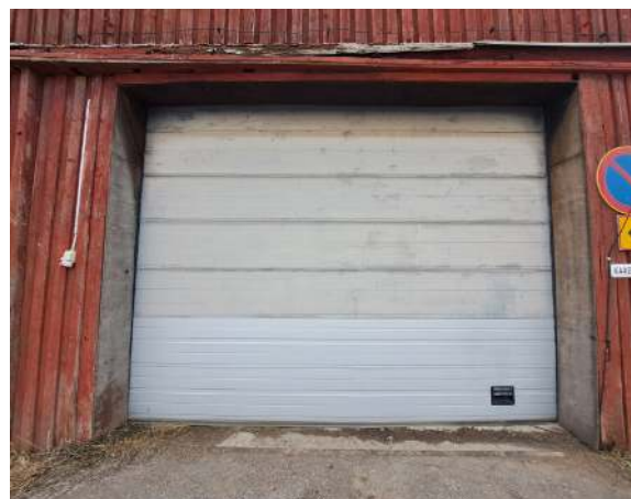
99. Verstaan O19 nosto-oveen on uusittu paneeleita.
