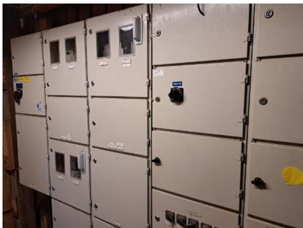
176. Sähköpää -ja kiinteistökeskus.
