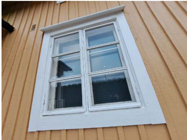
71. Asuinrakennuksen O10 ikkuna ulkopuolelta. Ulkopuolen puuosien pinnoite on hyvässä kunnossa.
