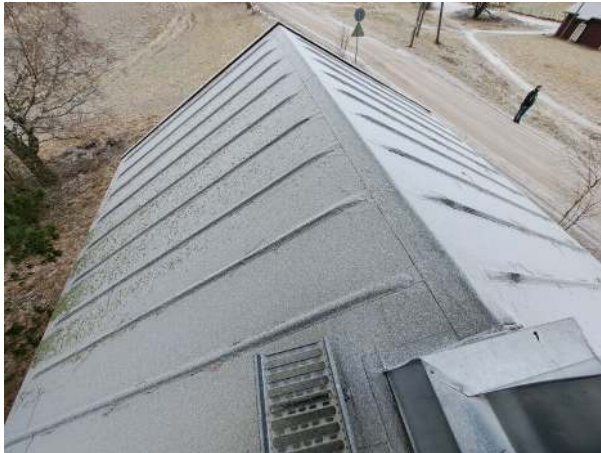
56. Asuinrakennuksen O02 vesikattoa.
