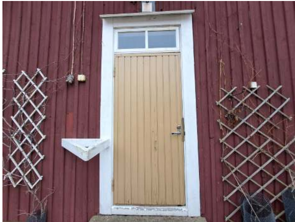
48. Asuinrakennuksen O02 ulko-ovi.
