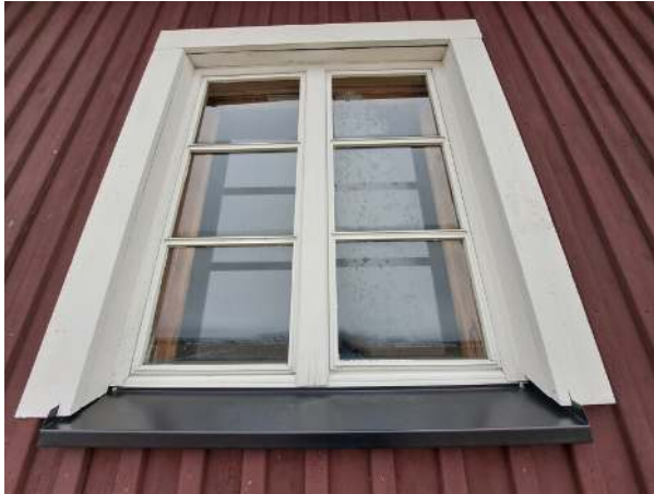
44. Kellarimäen saunan O34 ikkuna ulkopuolelta.
