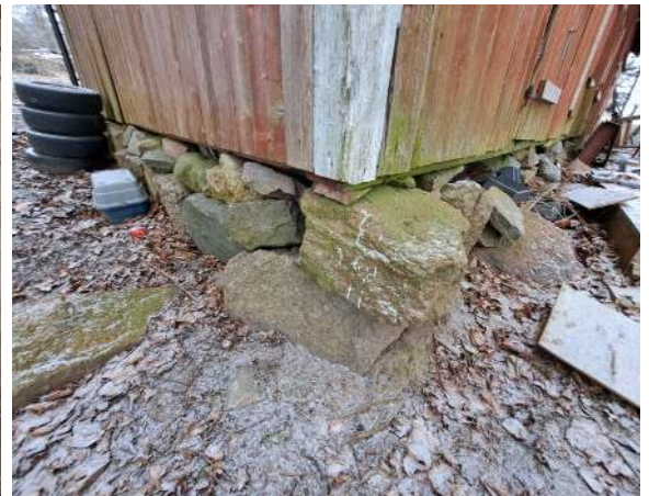
25. Niskalan talousrakennus on perustettu osin kiviladonnan varaan.
