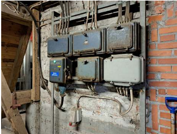
76. Kuivurirakennuksen sähköpääkeskus.
