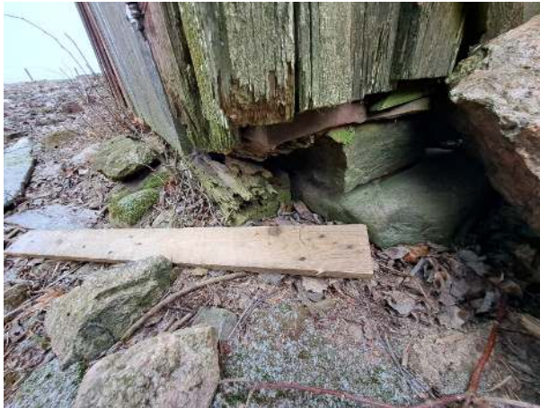
22. Kellarimäen talo 004 on perustettu kiviladonnan varaan.
