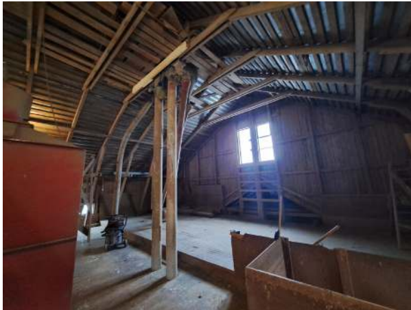
31. Kuivaamon 003 runkorakenteita.
