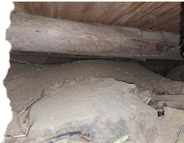
27. Kuvaa asuinrakennuksen 002 alapohjatilasta.
