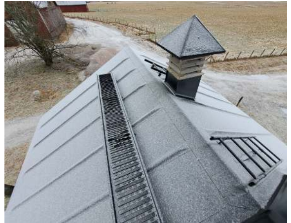
57. Kellarimäen saunan O34 vesikattoa.
