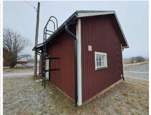
35. Kellarimäen saunan O34 julkisivua.
