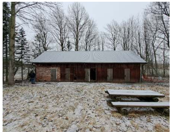
61. Niskalan talourakennuksen vesikattoa.
