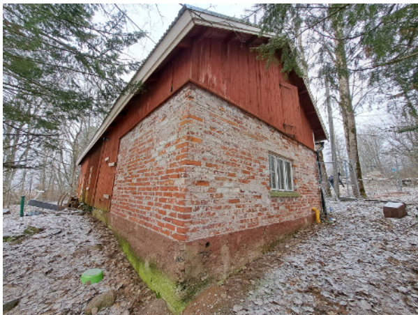
33. Niskalan talousrakennus on puu- ja tiilirakenteinen.
