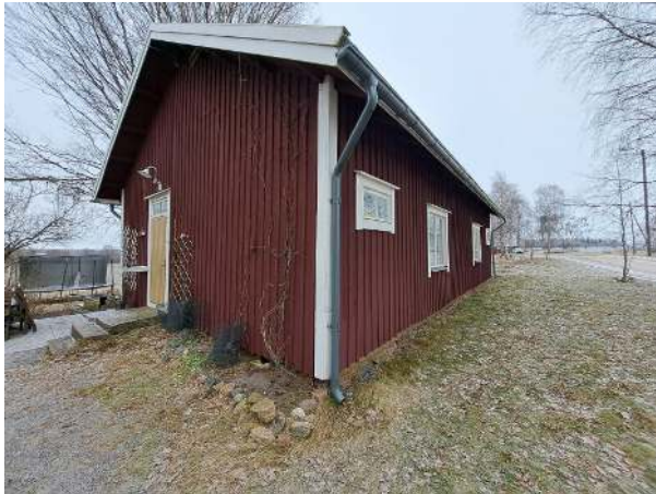
34. Asuinrakennuksen O02 julkisivua.
