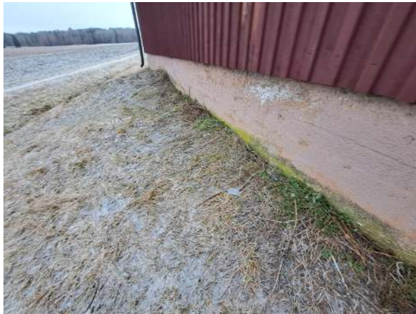
5. Kellarimäen saunan O34 vierustaa.
