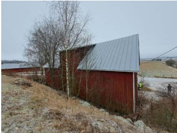
58. Kellarimäentalon O04 vesikattoa.
