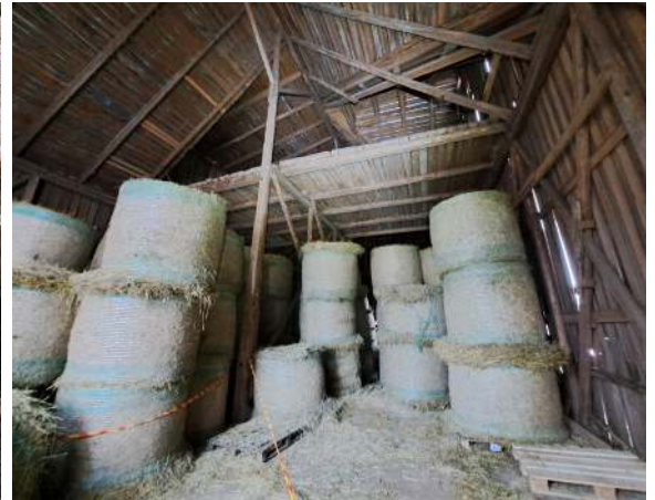
30. Kellarimäen talon 004 runkorakenteita.
