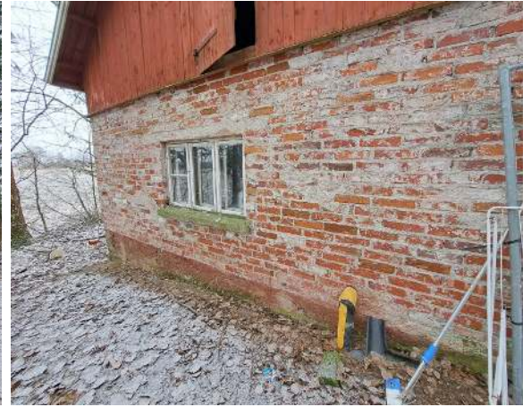
41. Niskalan talousrakennuksen tiiliverhoilua julkisivua.
