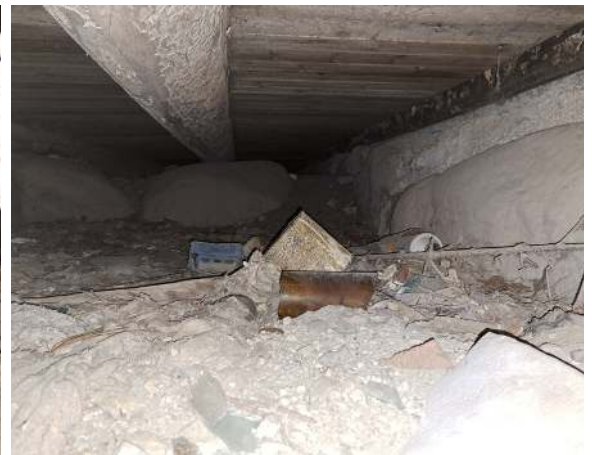
28. Kuvaa asuinrakennuksen 002 alapohjatilasta.
