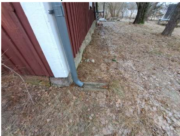
3. Asuinrakennuksen 002 kattovesien ohjausta.
