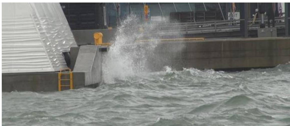
Kuva 11: LJ8 laiturin ajoramppi aallokossa. Ramppi heijastaa huomattavan osa aallokosta ja siksi vaimentaa syvemmällä Ahdinaltaassa olevaa aallokkoa merkittävästi siitä mitä altaan kapeneminen muuten aiheuttaisi. Ramppi toisaalta kasvattaa aallokkoa Neptununpuistossa ja varsinkin sen avomereltä suojatussa pohjoisreunassa
