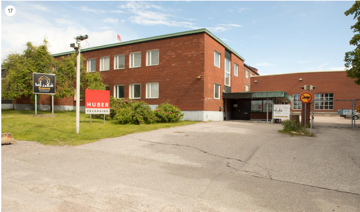
Julkisivut ovat puhtaaksimuurattua punatiiltä, ja seuraa näin alkuperäisen tehdasrakennuksen piirteitä. Sokkeli on betonia. Katokset ja kattolistat ovat kuparia. Ikkunat ovat alkuperäisiä, valkoiseksi maalattuja puuikkunoita. Oikealla puolella näkyvät portinpylväät ovat punatiilestä muurattuja ja alkuperäisen kaltaisia.
