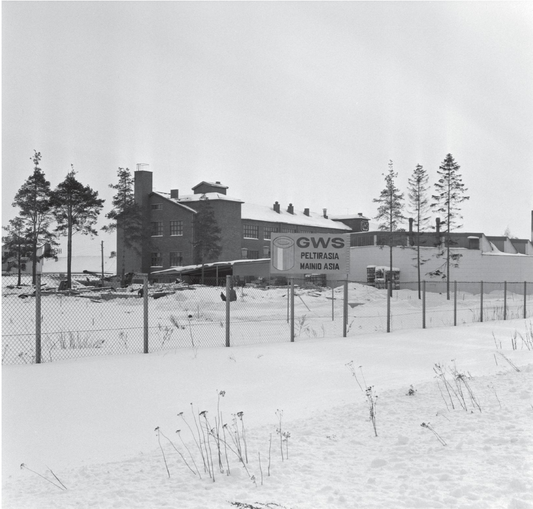
Tehdas kuvattuna luoteesta itäväylän suunnalta vuonna 1960. Savupiipputorni purettiin vuoden 1984 laajennusosan rakentamisen yhteydessä. Kienanen, HKM.
