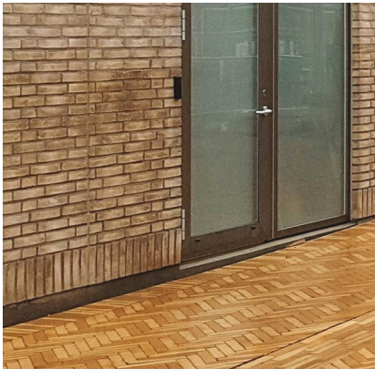
TIILIMUURAUUS, MATALA SOKKELI JA MAATIILI
