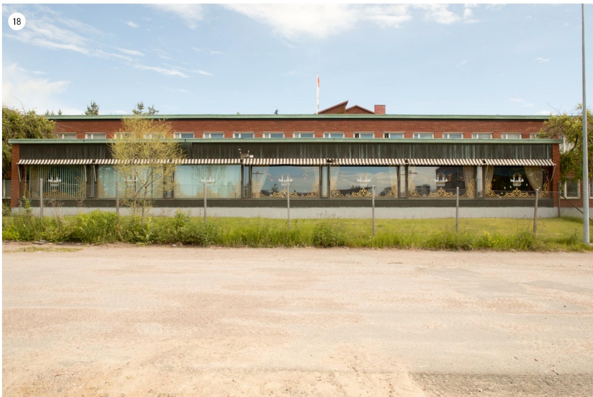
Toimistorakennuksen eteläisivulla on rakennusmassasta ulkoneva yksikerroksinen osam jonka julkisivussa on kuparilevyä ja suuret ikkunapinnat.
