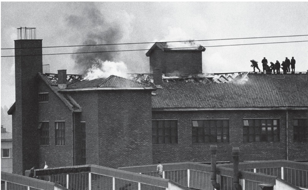
Alkuperäisen tehdasrakennuksen katon tulipaloa sammutetaan vuonna 1962. Leo Riihelä, HKM.
