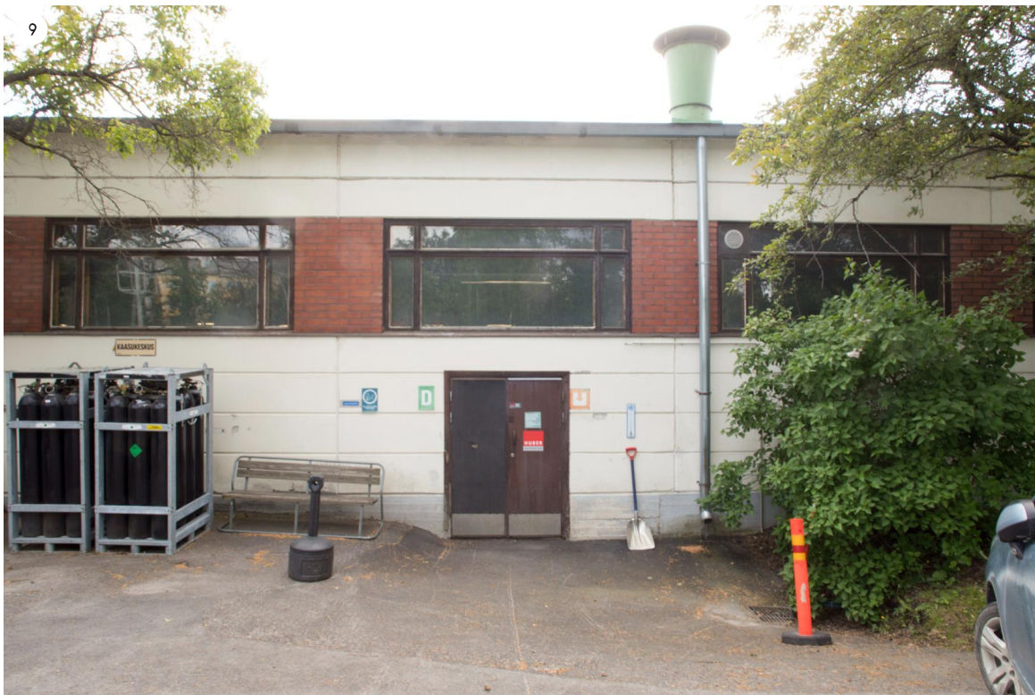
Laajennukset vuosilta 1963 (1d) ja 1966 (1e) yhsiytyvät toisiinsa melkein saumattomasti.
