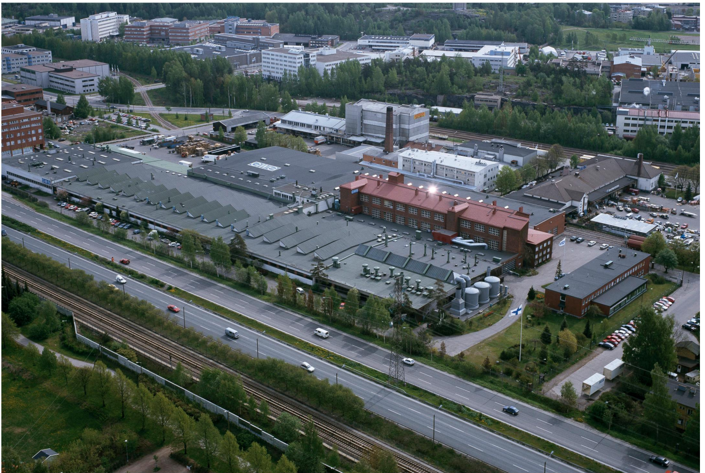
Viistoilmakuva Työnjohtajakatu 1:en rakennuksista vuodelta 1991. Kortteli on nykyisen kaltainen. Scan-foto, HKM.
