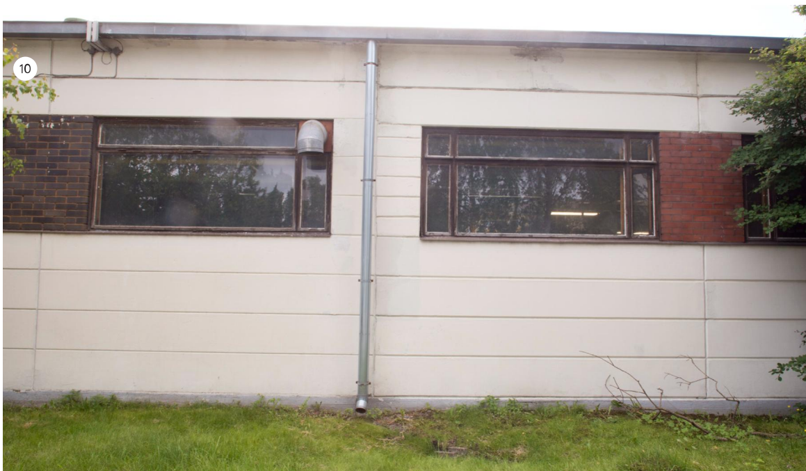
Vuosien 1963 (1c) ja 1966 (1 d) laajennusten liitoskohta. Materiaalit ja massoittelevä pysyvät samoina, mutta tiilidetallit on muurattu tummammasta tiilestä.
