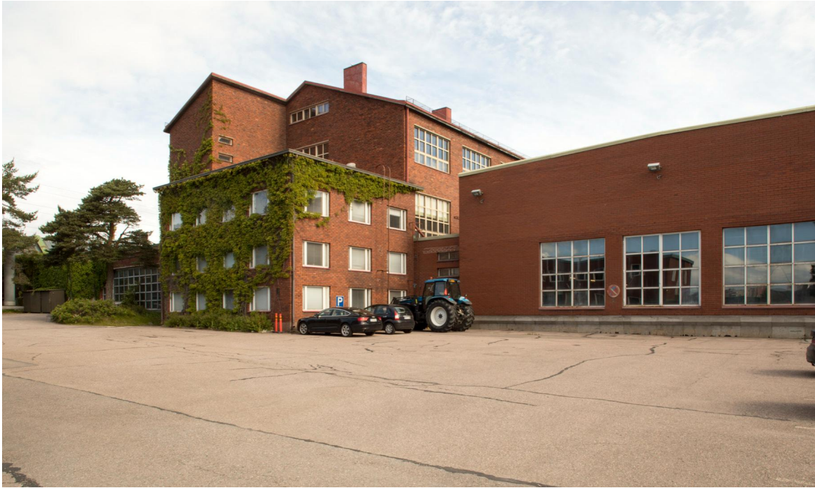
Tehdasrakennuksen eteläjulkisivussa yhdistyy monia eri rakennusvaiheita
