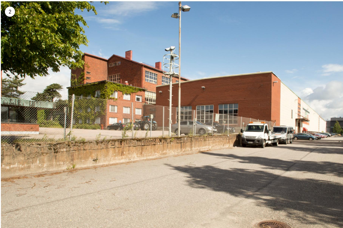
Tehdasrakennusten eteläjulkisivut ovat puhtaaksimuurattua punatiiltä. Eteläpuolen eriaikaisten rakennusosien julkisivut ovat yhtenäisiä.
