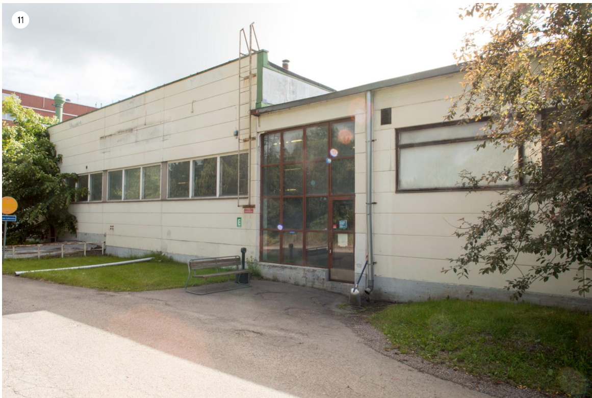
Länsilaidan viimeinen laajennusosa on vuodelta 1971 (1h) ja erottuu kokeampana massana. Liitokohtaan vuoden 1966 (1e) rakennuksen kanssa rakennettiin välikappale, jossa on iso ikkunapinta. Julkisivut ovat Siporex-elementtiä.
