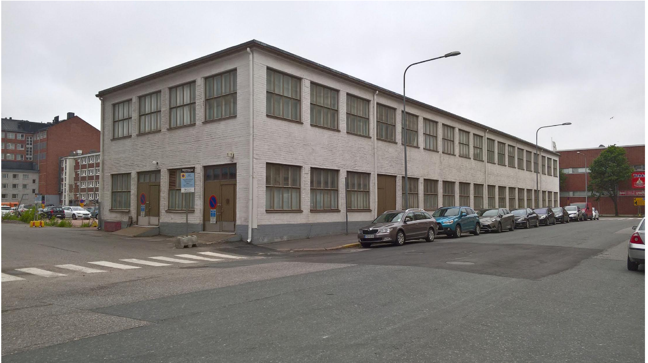
Asemakaavan muutosehdotus nro 12390, kuvaliite suojelukohteesta Taiteilijatalo osoitteessa Verkkosaarenkatu 1 / Vanha Talvitie 9 idästä kuvattuna
