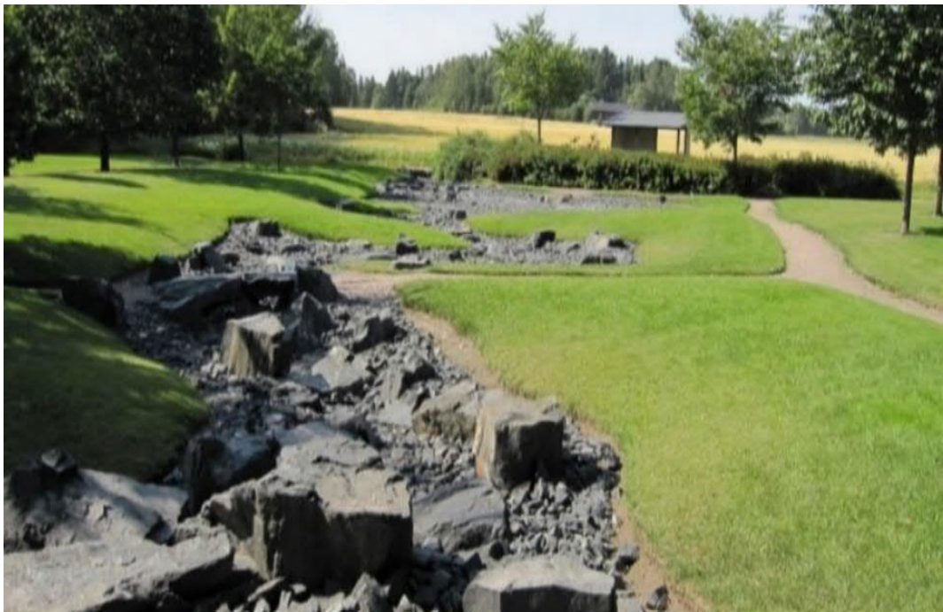
Kuva 1. Hulevesien viivytyksrakenne Eko-Viikissä.
