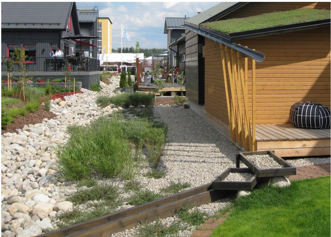
Kuva 3. Esimerkki hulevesien hallintajärjestelyistä Jyväskylän asuntomessualueelta.
