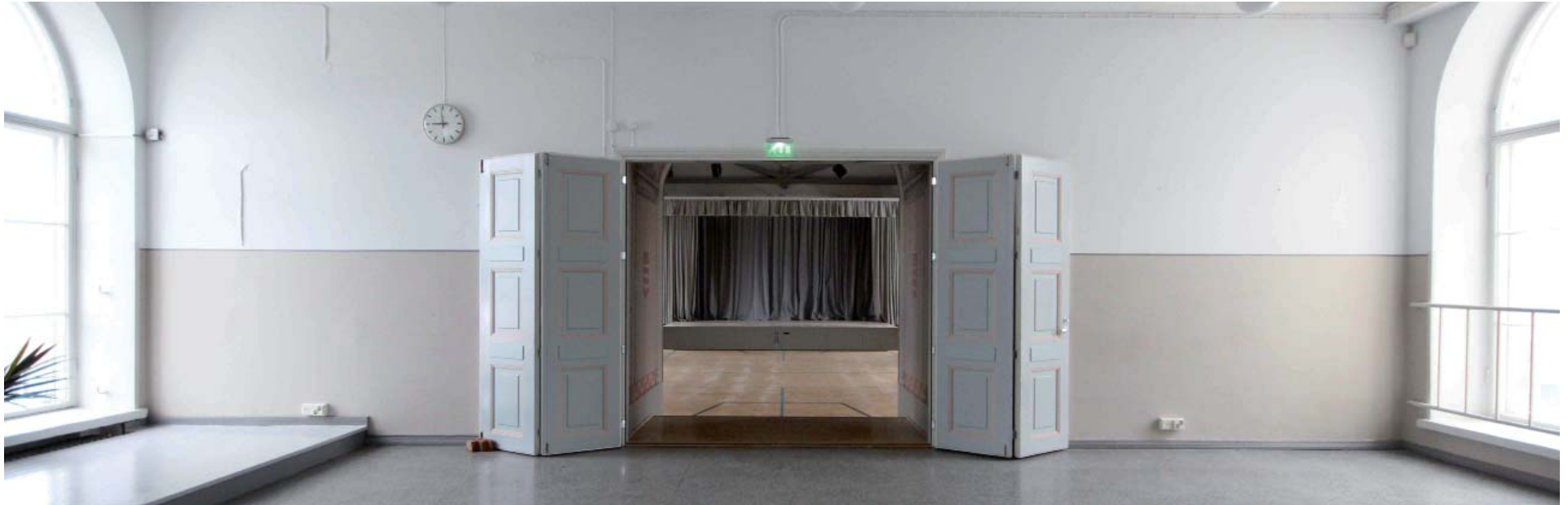
Ylhäällä 3. kerroksen aula, juhlasalin pariovet avattuina, oikealla alhaalla aula ja suljetut pariovet
