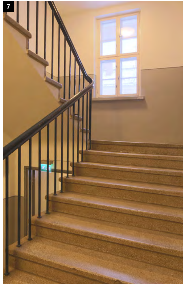
↑ Porrashuoneen yleisilme on säilynyt alkuperäisenä. Seinäväritystä ja ikkunoita on uusittu alkuperäisen mallin mukaan.
