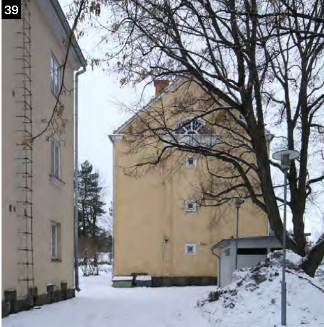
↑ A-rakennuksen koillispääty avautuu Loviisankadun suuntaan. Kuvassa oikealla jätekatos, joka on rakennettu vuonna 2010.
