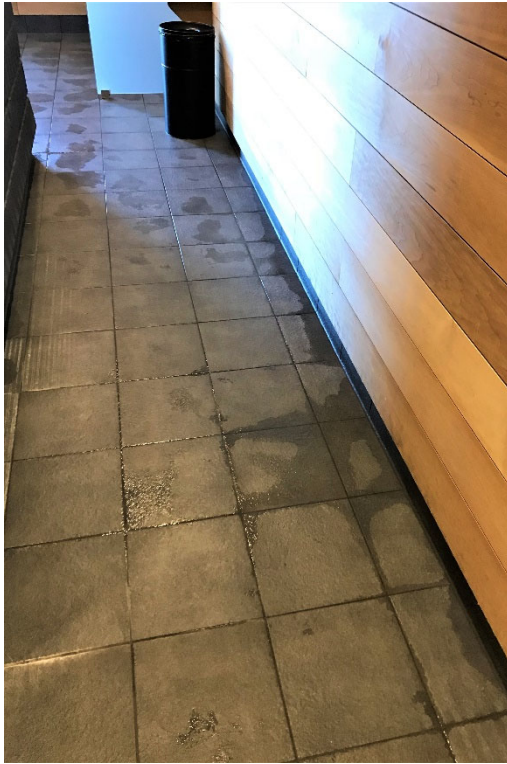
Kuva 21. Lattialle jää vettä seisomaan. LK.
