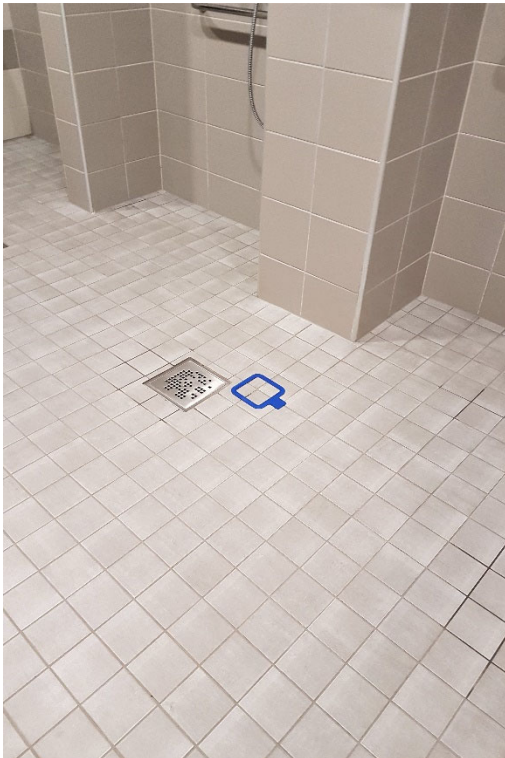
Kuva 8. Näytteenottopiste 3. Pesutila, lattiakaivon välitön läheisyys. AH.
