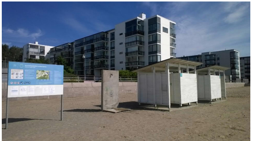
Utomhusdusch och omklädningshytter vid Solvik
