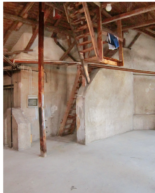
Ullakkorakentaminen vaatii erityistä käsityötaitoa ja huolellista työn jälkeä. (Yllä) Museokatu 30, ullakotila (Vasen) Kauppiaankatu 4
