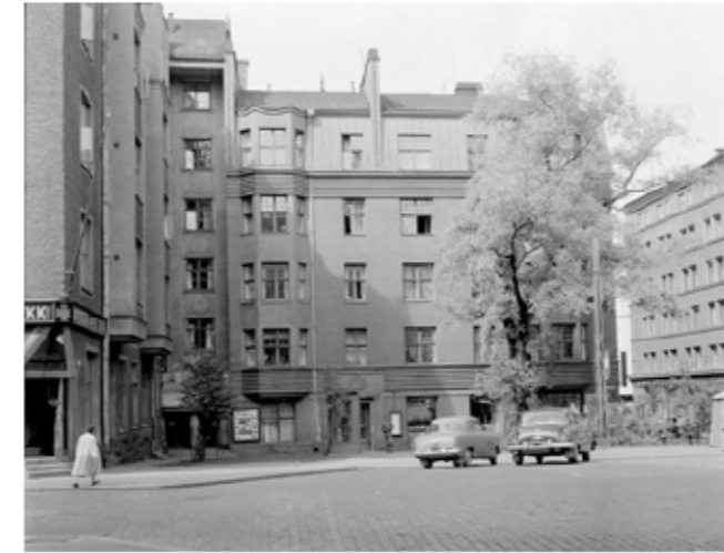
Viereinen sivu: Punavuorenkatu 1:n kivijalassa toimi pitkään apteekki, joka lopetti toimintansa vuonna 2019. Kuva Järvinen, Ilari 1995. HKMKA.
