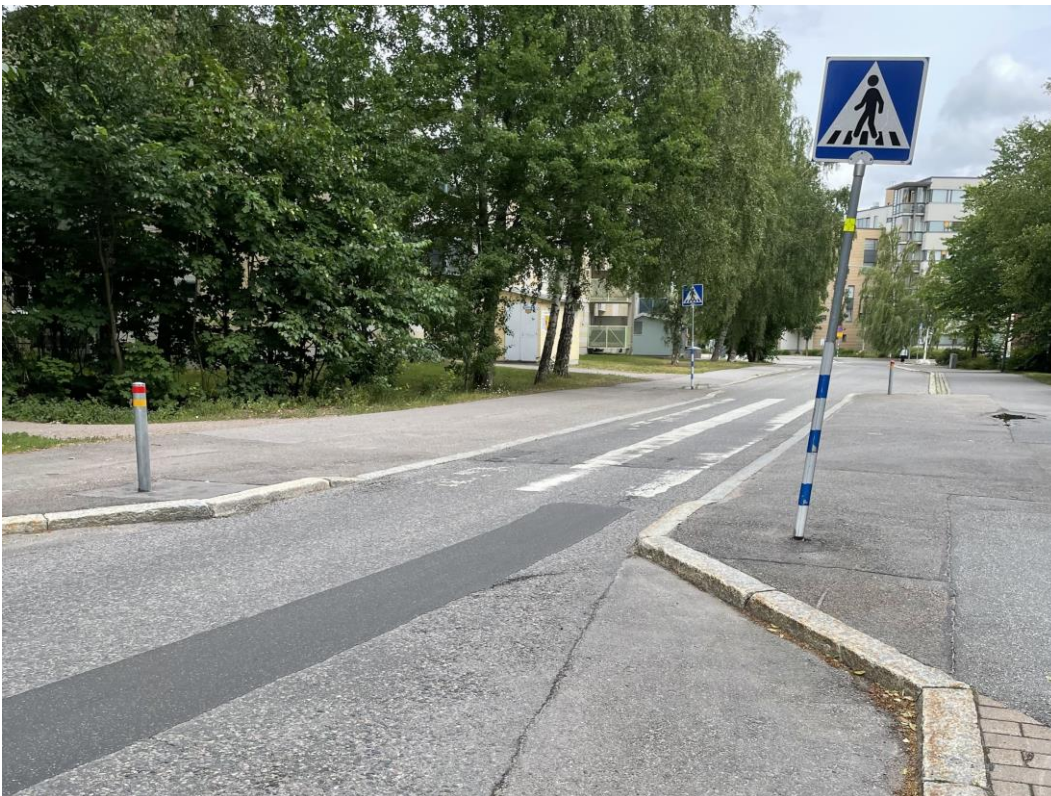
Kuva 7.1. Näkymä Otto Brandtin tien ylittävälle suoja-tien kavennukselle koulun eteläpuolella.
