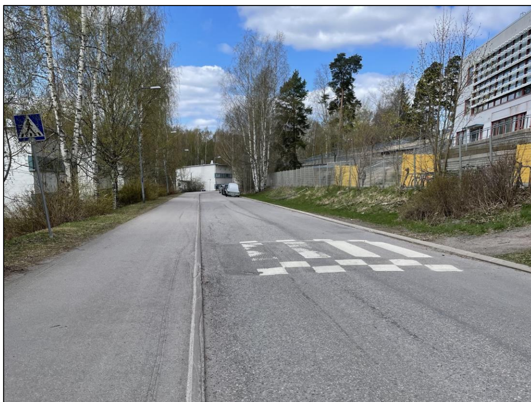
Kuva 7.19. Naulakalliontien korotettu suojatie koulun kohdalla.
