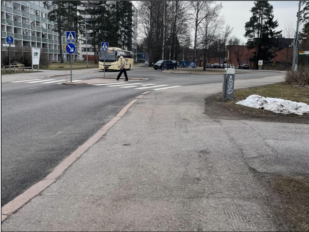
Kuva 7.7. Näkymä Keinutien käänntöpaikalle ja käänntöpaikan yhteydessä olevalla keskisaarekkeelliselle suojatielle. Keinutien toimipiste ja Keinupolku sijaitsevat kuvassa käänntöpaikan takana.
