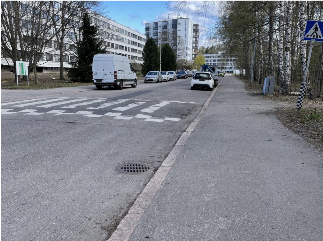
Kuva 7.13. Naapurintien korotettu suojatie Helsingin yhteislyseon länsipuolella. Kuvassa oikealla alkaa puistoreitti lyseolle.
