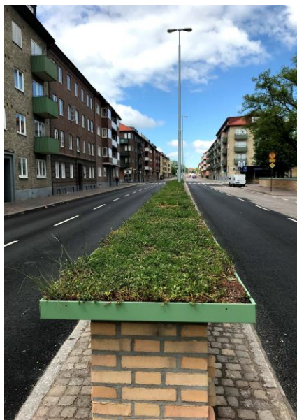
Kuva 14. Tiilestä rakennetun meluseinäkkeen maksaruohopintainen viherharja. Kuva Efterklang (2020)
