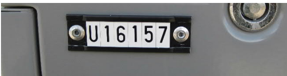
Kuva 14. Esimerkki ulkovalaistuskeskuksen merkitsemisestä.
