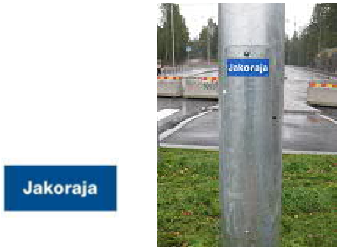
Kuva 10. Esimerkki jakorajatarran kiinnityksestä valaisinpylväeseen. Tarran leveys on 100 mm ja korkeus 40 mm.
