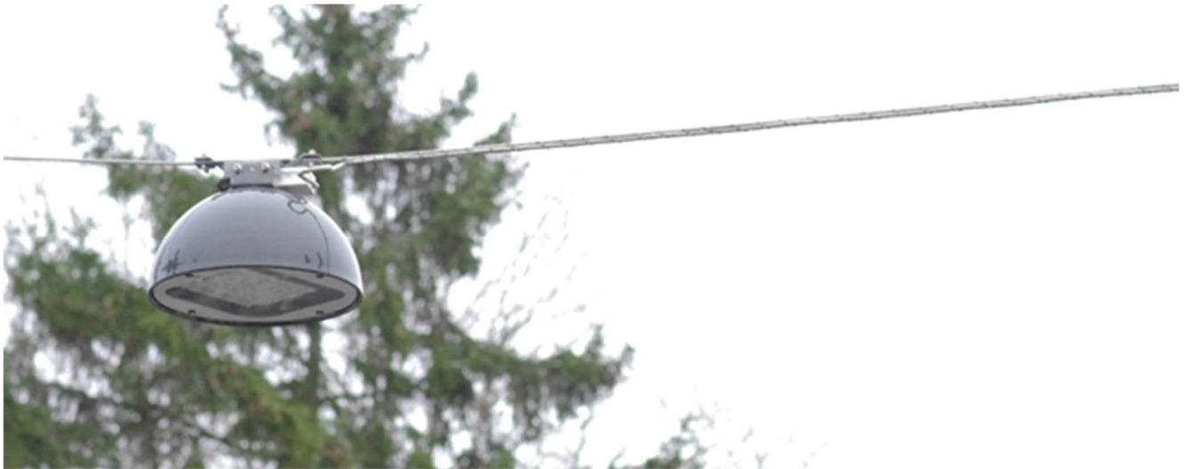
Kuva 8. Esimerkkikuva valaisinjohton surrauksesta ripustusvaijeriin.
