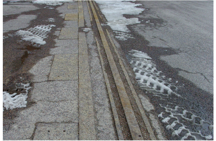
Hietalahdenlaiturin kansitasossa oleva nosturin kisko.
