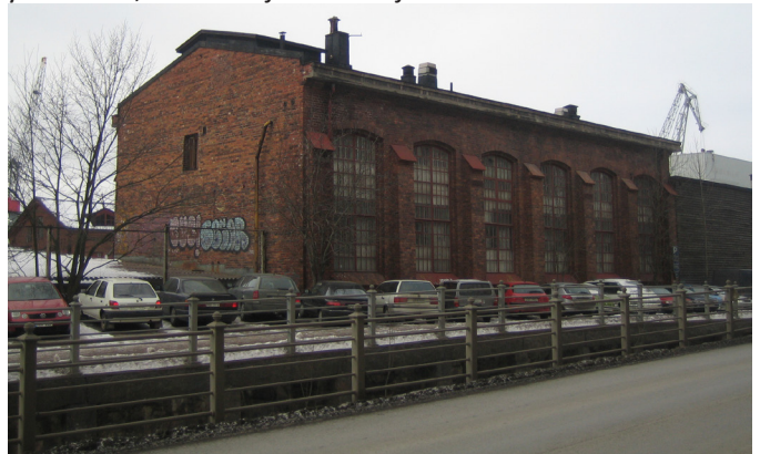
Telakkakatu ja satamaratakuilu
